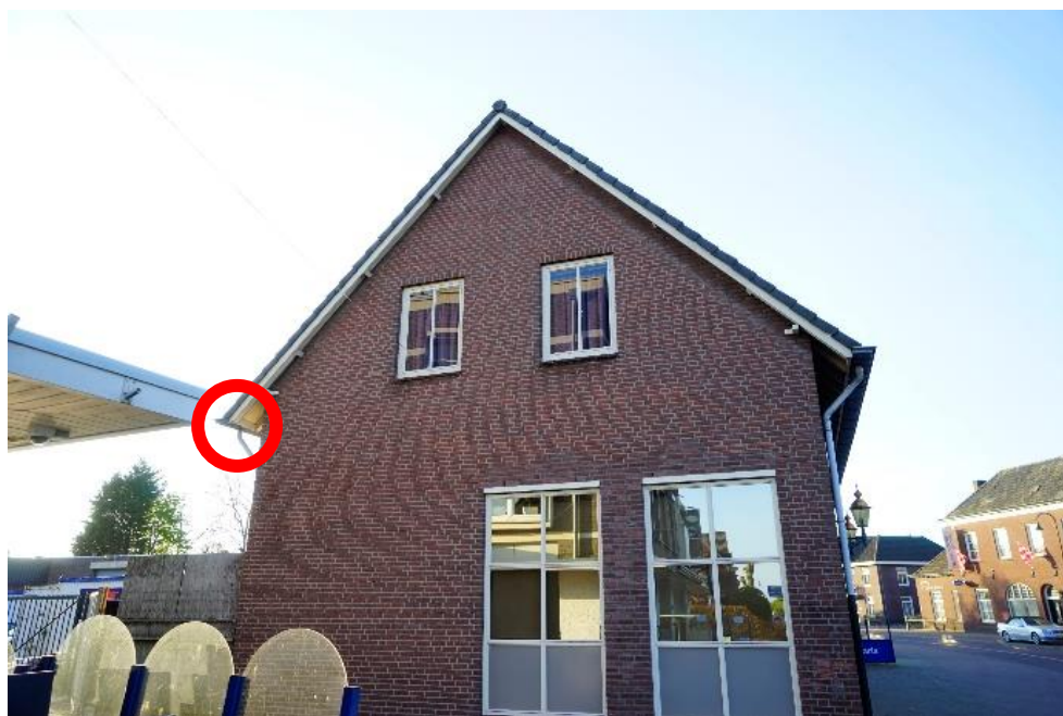
Figuur 3 Noordelijke gevel van Hoofdstraat 53 met een zomerverblijfplaats van de gewone dwergvleermuis (rood omcirkeld).
