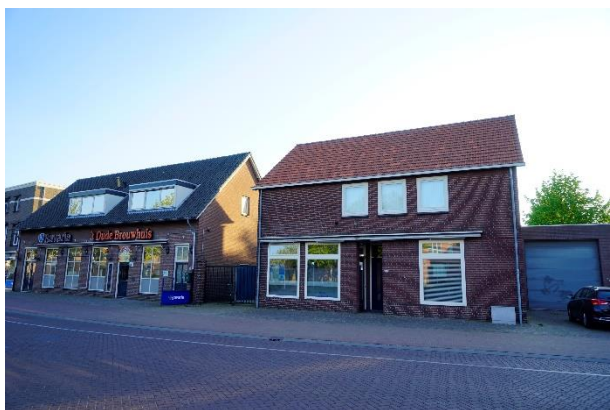
Voorzijde van de woningen (nummer 51 rode dakpannen; nummer 53 zwarte dakpannen)
