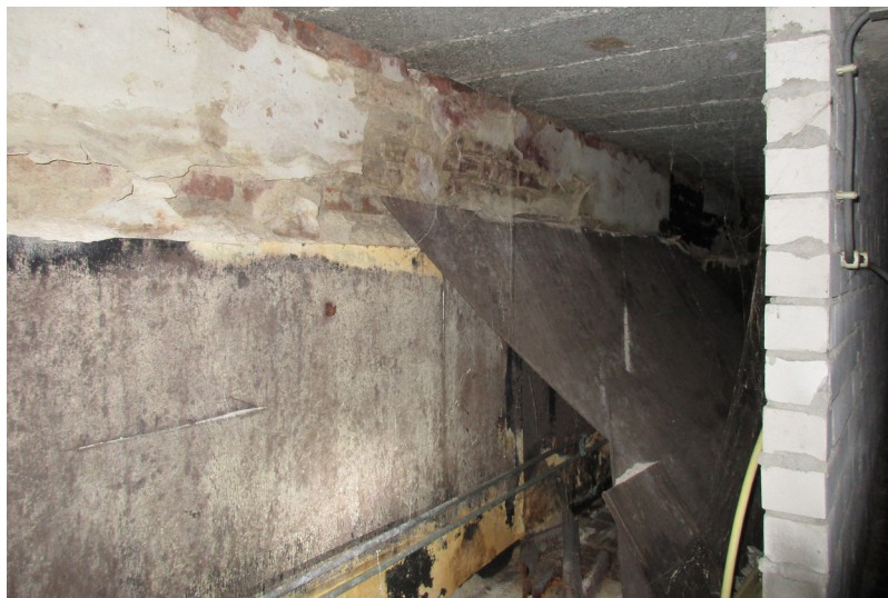
Kelder/ kruipruimte in het linker deel onder de cafévloer, de gemetselde muur dateert uit 1912.
