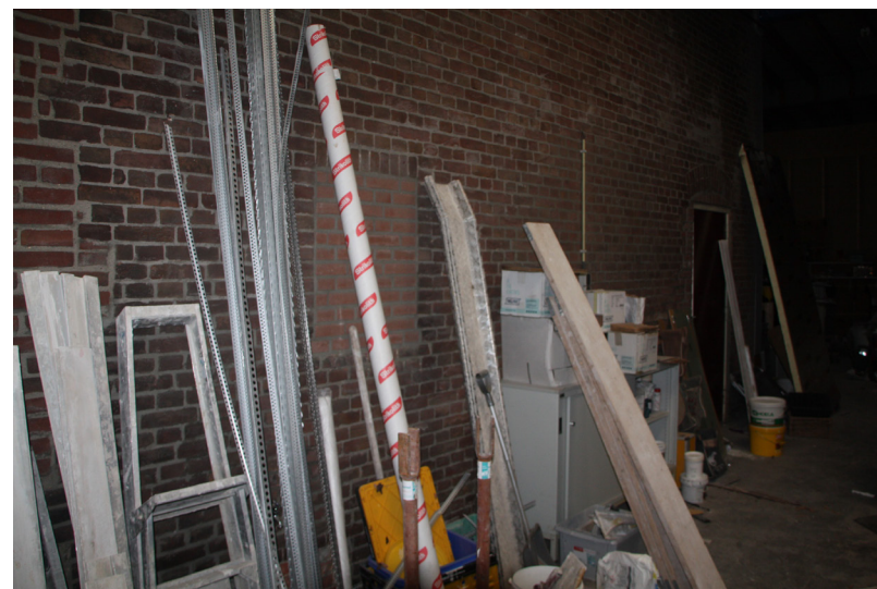
Voormalige buitengevel van de opslagruimte (1913).
