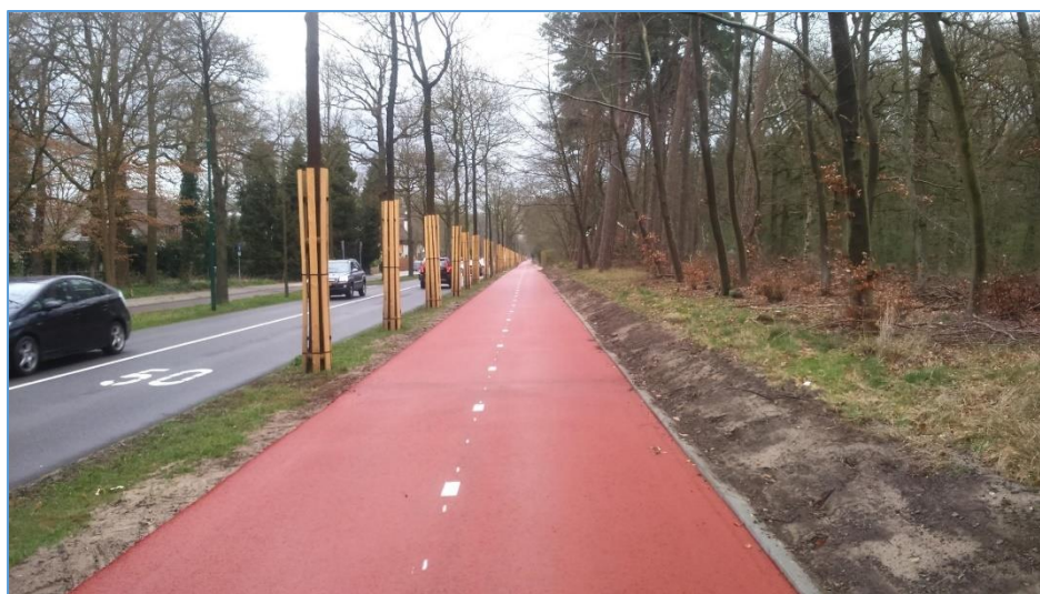
Foto 9: Praktijkvoorbeeld boombescherming door stamommanteling
