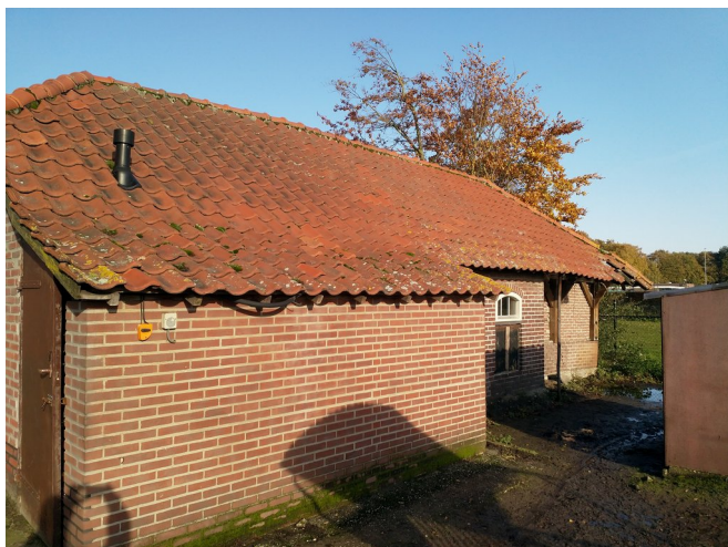
Afbeelding 7: Ruimtes onder de dakpannen welke potentieel geschikt kunnen zijn als vast rust- en verblijfplaats van huismus. Foto: M. de Vries | Ecoresult B.V.
