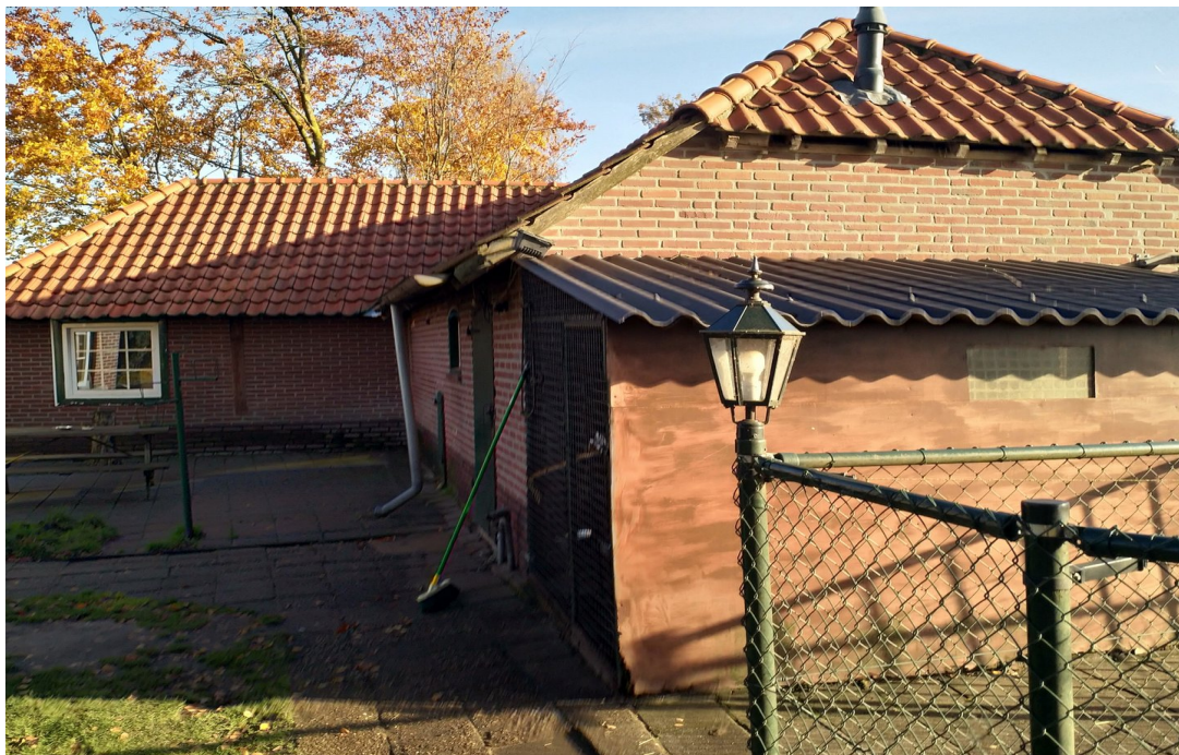
Voor- en zijgevel van het oude woonhuis (Gebouw 1) kijkend richting het oosten. Foto: M. de Vries / Ecoresult B.V.
