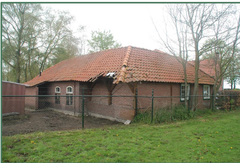
Te slopen gebouw 2
