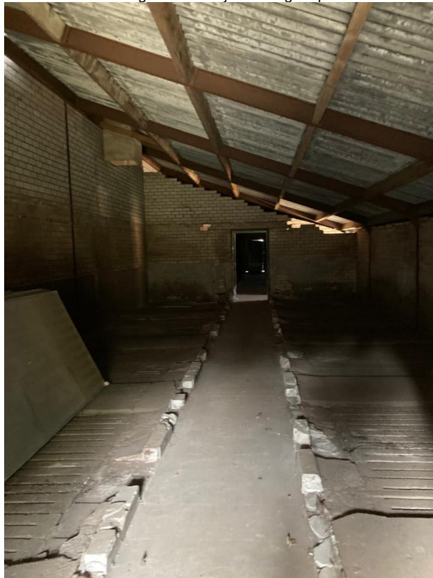
• Afbeelding 20: binnenzijde reeds gestripte varkensstal
