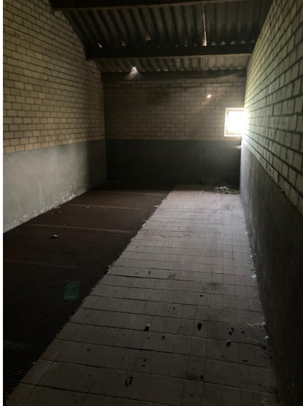
• Afbeelding 17: binnenzijde reeds gestripte varkensstal
