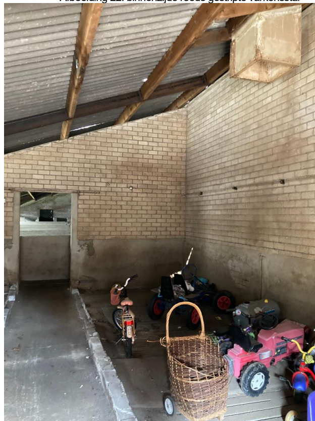
• Afbeelding 22: binnenzijde reeds gestripte varkensstal
