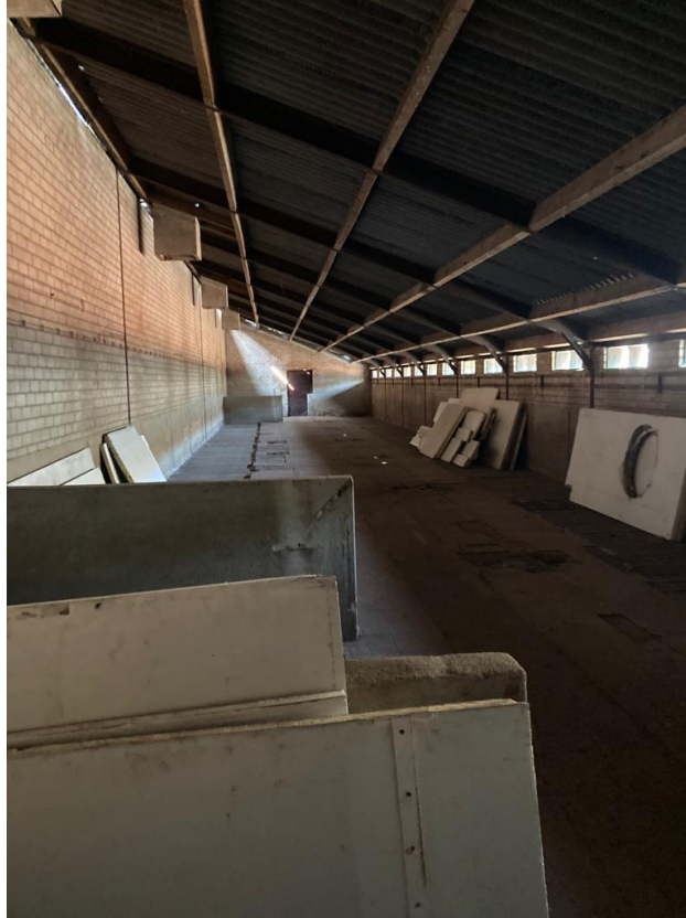
• Afbeelding 25: binnenzijde reeds gestripte varkensstal
