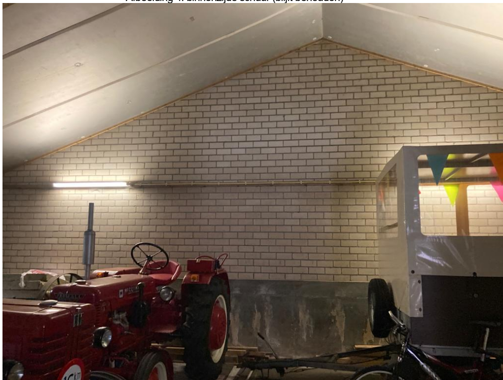
• Afbeelding 4: binnenzijde schuur (blijft behouden)
