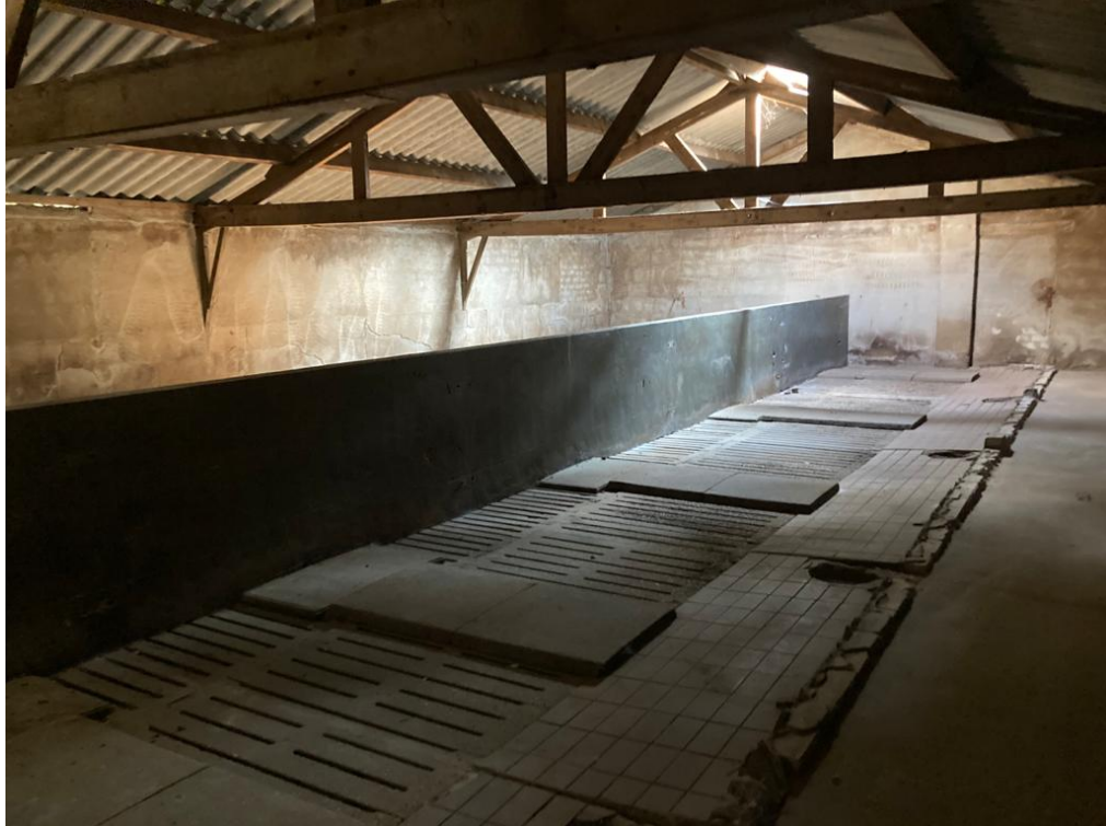
• Afbeelding 21: binnenzijde reeds gestripte varkensstal
