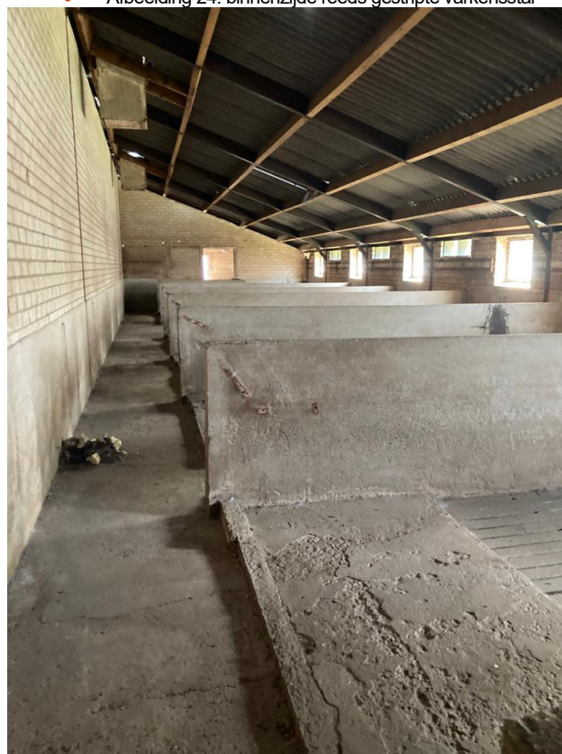
• Afbeelding 24: binnenzijde reeds gestripte varkensstal
