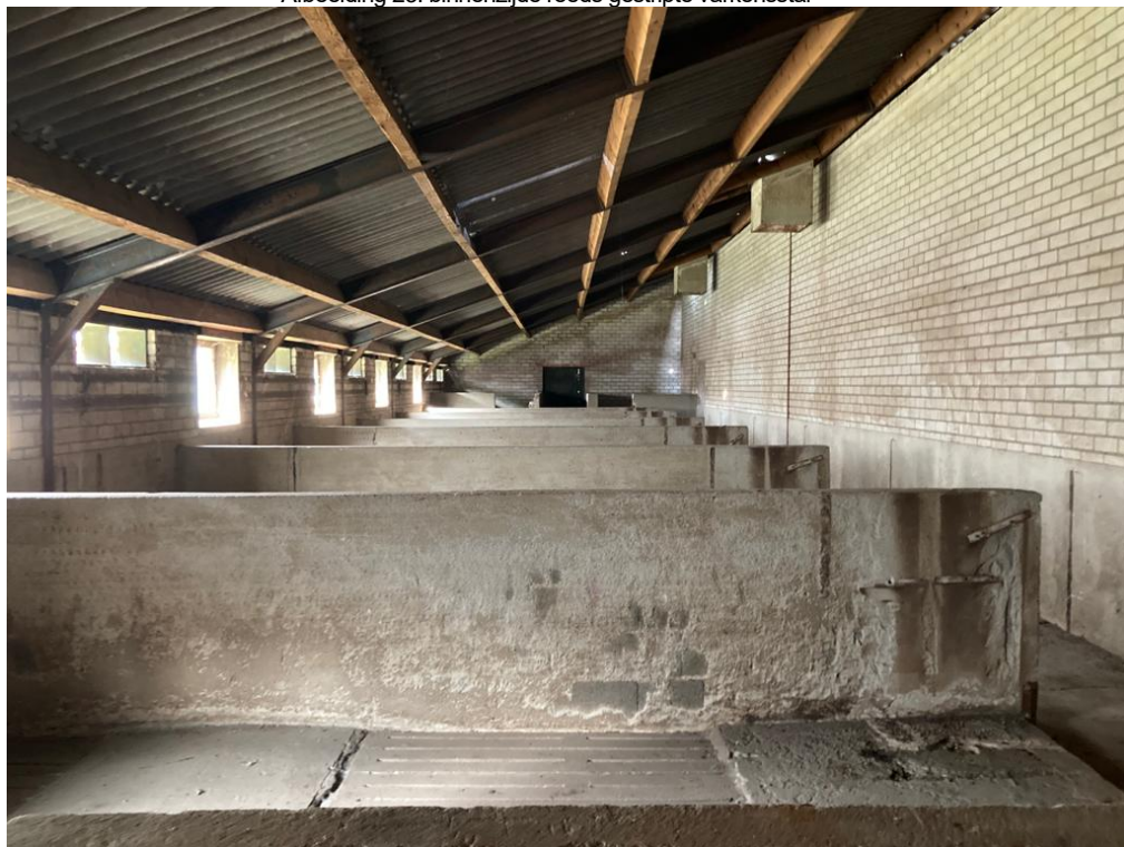
• Afbeelding 23: binnenzijde reeds gestripte varkensstal
