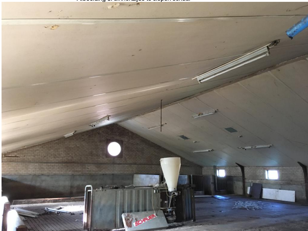
• Afbeelding 8: binnenzijde te slopen schuur
