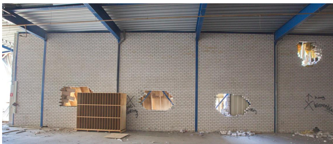
Figuur 30: Overzicht binnenmuur (vermeende verblijfplaats, zie figuren 22 t/m 26) d.d. 9-3-2022.
