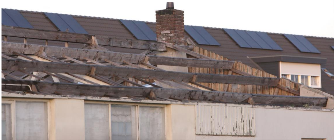
Figuur 13: Restant dak met schoorstenen (linker schoorsteen niet in beeld).
