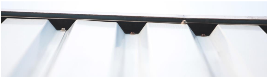
Figuur 10: Zicht op de aansluiting van de damwand aan de buitenzijde op het dakdeel.
