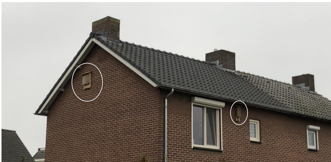
Figuur 27: Kleine kolonie en paarkast aan de gevel van naastgelegen woning aan de Steenovenweg op locatie A, (zie tevens figuur 18).
