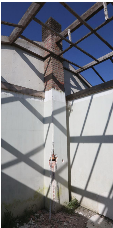
Figuur 31a: Schoorsteen met tochtgat (zie figuur 17).
