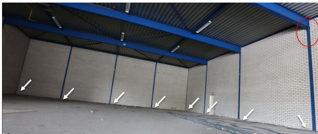
Figuur 8: Intern deel van het nog in tacte deel van de loods. Hier zijn géén invlieg mogelijkheden geconstateerd. De dragende stalen balken rusten op de in de muur verankerde stalen staanders. Witte pijlen duiden op locaties waar keutels te verwachten zijn indien de spouw vanuit de binnenzijde wordt ingevlogen.
