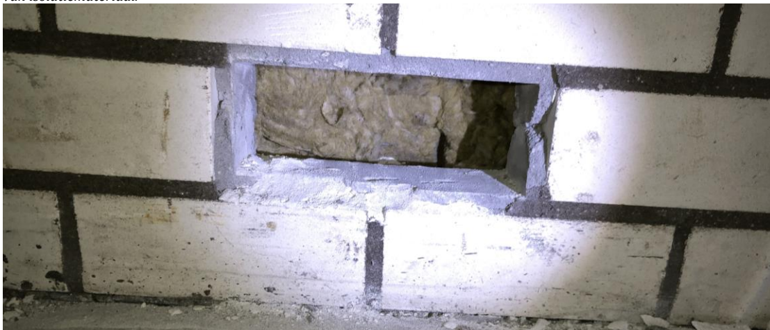
Figuur 26: inwendige delen overige muren. Alle delen zijn voorzien van isolatiematerialen.
