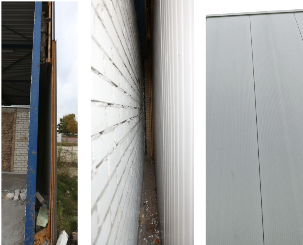
Figuur 9: Open gewerkte spouw van de noordwand van de loods (vergelijk met figuur 5). Van links naar rechts: (i) open gebroken spouw, (ii) binnenzijde spouw en (iii) wand buitenzijde.
