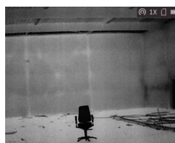
Figuur 19c: Intern zicht Loods
