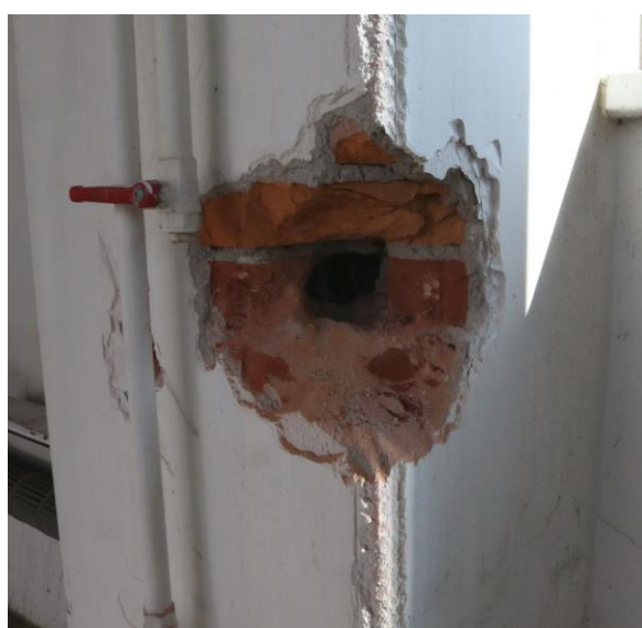
Figuur 32b: Tochtgat in detail
