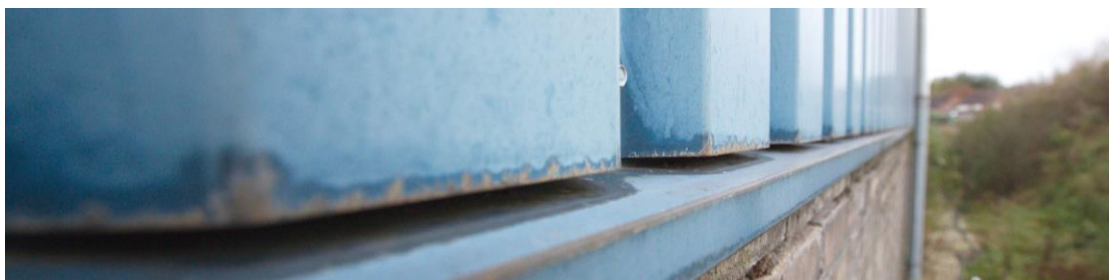
Figuur 11: Zicht op de onderzijde van de damwandconstructie aan de buitenzijde van de loods. Bovenzijde is identiek gebouwd. Hierdoor is toegang tot de spouw voor vleermuizen uitgesloten.
