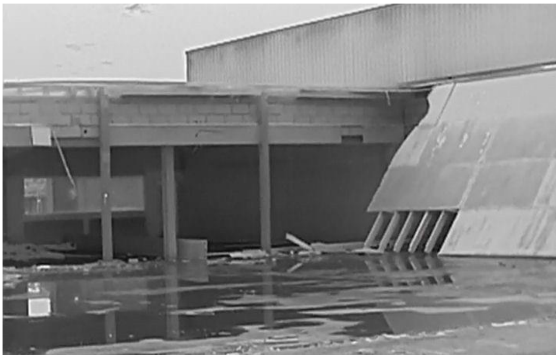
Figuur 18: Zicht op Loods en bijgebouw A middels warmtebeeld vanaf positie 2.
