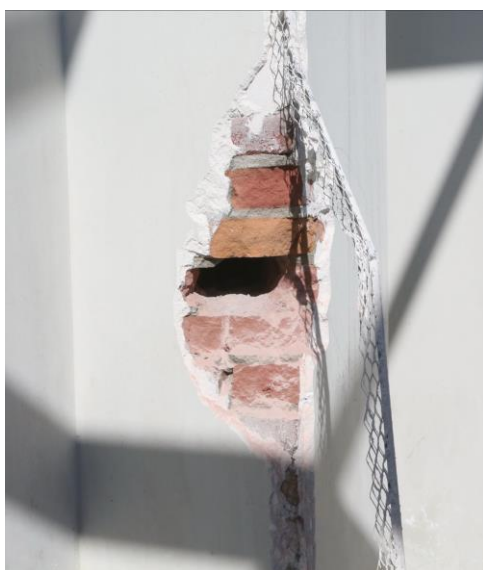
Figuur 31b: Tochtgat in detail
