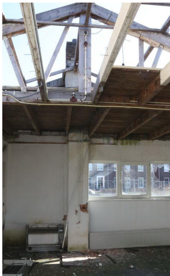
Figuur 32a: Schoorsteen met tochtgat (zie figuur 17).
