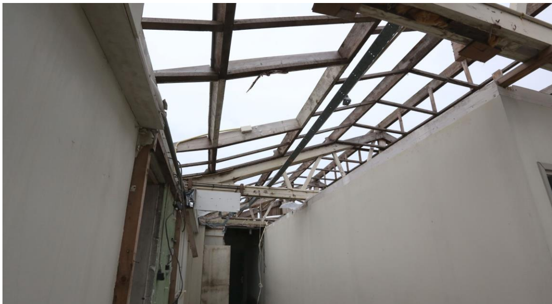
Figuur 14: Intern zicht op bijgebouw B.
