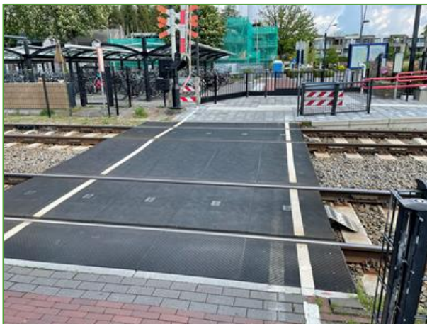
Figuur 20 Voetgangersovergang station Deurne (hoofdspoor).
