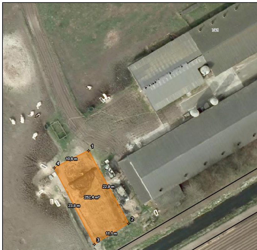
Afb. 11. Te saneren voerplaat
