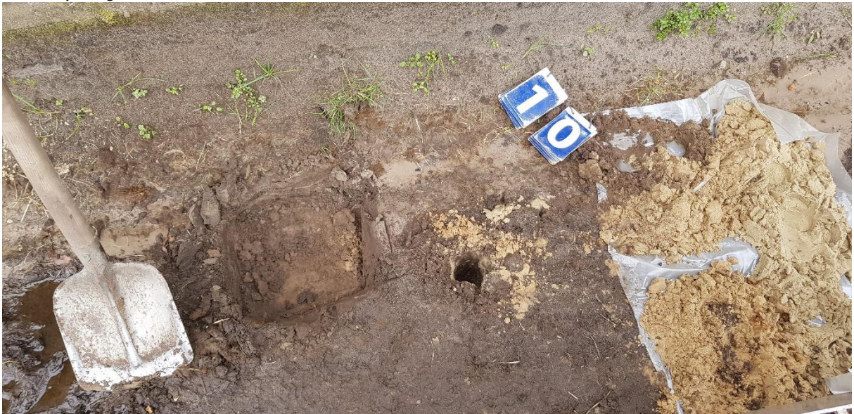
Foto's inspectiegaten en sleuven
