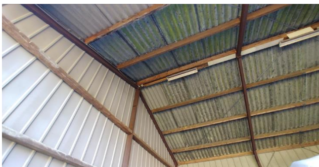
Figuur 8: Binnenzijde garage
