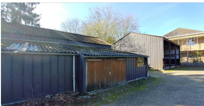
Figuur 7: Schuur en garage tegen zuidelijke perceelgrens
