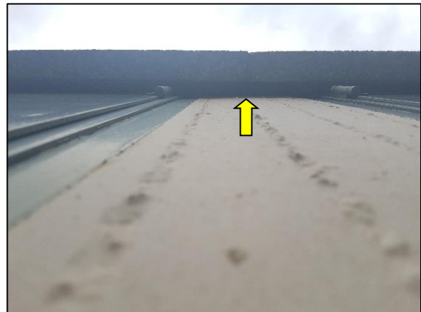
Figuur 11. Ruimte achter betonnen daklijst waardoor vleermuizen geschikte ruimtes in de bebouwing kunnen bereiken.
