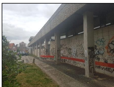
Figuur 7. Westzijde van de te slopen bebouwing.
