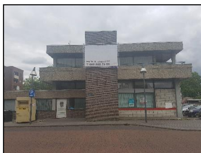
Figuur 4. Noordzijde van de te slopen bebouwing.
