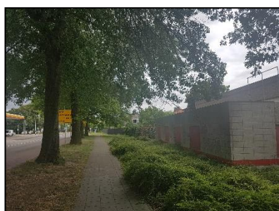
Figuur 6. Zuidzijde van de te slopen bebouwing (rechts) met bomenrij langs de Hogeweg.
