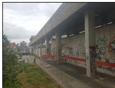
Figuur 7. Westzijde van de te slopen bebouwing.
