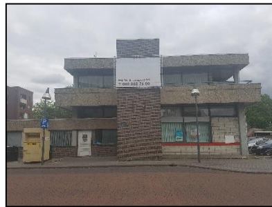
Figuur 4. Noordzijde van de te slopen bebouwing.
