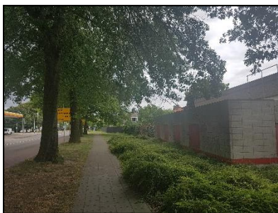
Figuur 6. Zuidzijde van de te slopen bebouwing (rechts) met bomenrij langs de Hogeweg.
