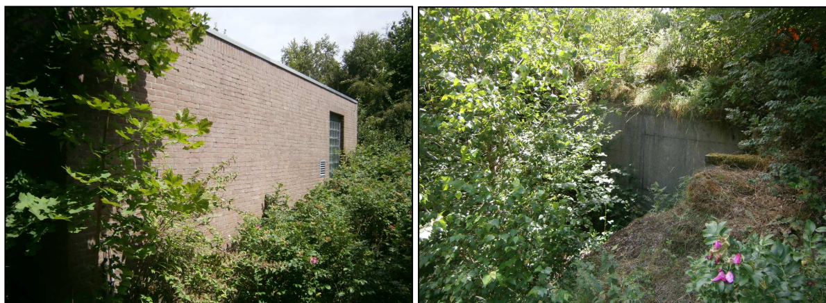
Figuur 16: Beeld van overwoekerde bebouwing binnen het plangebied, met op de linker foto het opjaagstation en op de rechterfoto de reinwaterkelder
