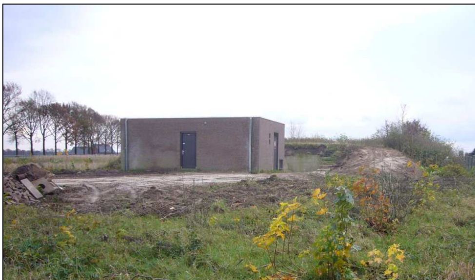
Figuur 8: Beeld van het opjaagstation, waarachter de reinwaterkelder gelegen is voor totstandkoming van de huidige aanwezige natuurlijke opslag
