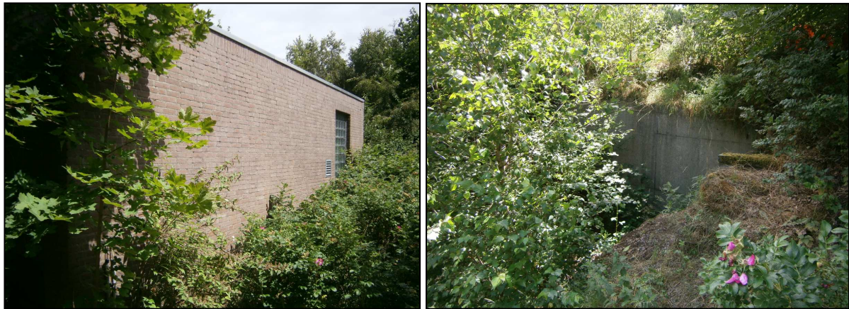
Figuur 15: Beeld van overwoekerde bebouwing binnen het plangebied, met op de linker foto het opjaagstation en op de rechterfoto de reinwaterkelder
