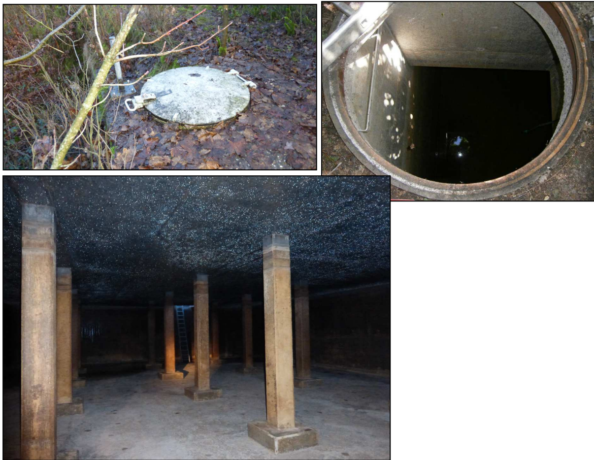
Figuur 13: Beeld van toegang en inrichting van de reinwaterkelder
