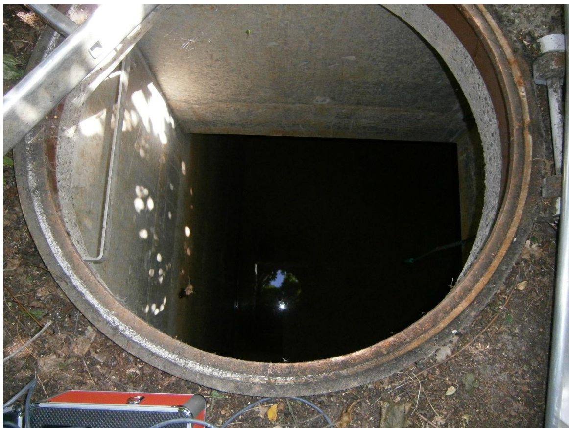
Afb.21. Toegang tot de westelijke reinwaterkelder.
