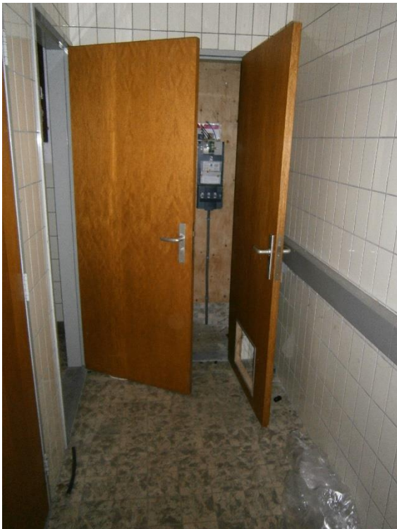
Afb.15. Opjager, hal richting meterkast en toilet.
