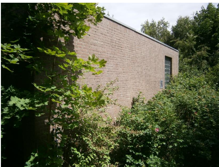
Afb.13. Opjager, gevel zuidzijde.
