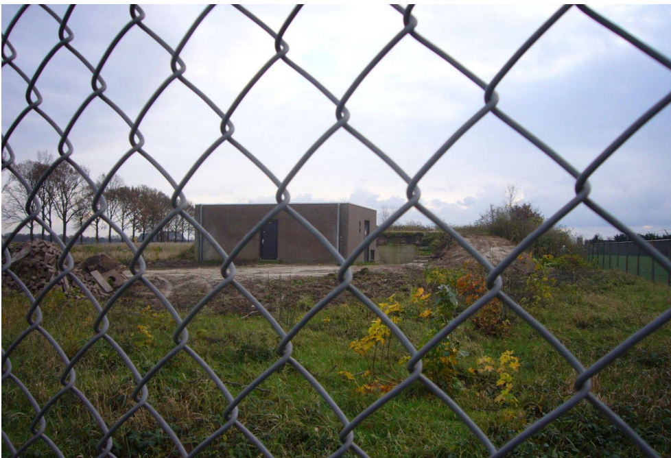
B4.5 Rondom het talud van de reinwaterkelder is een rand met struiken te zien.
