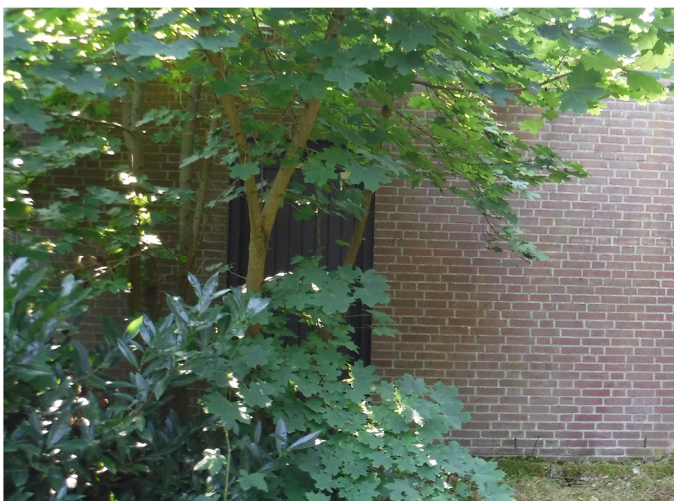
B4.3 De ingang van de opjager gaat schuil achter de plaatselijk dichte begroeiing.
