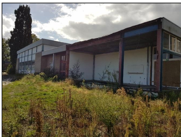
Figuur 3. Oostzijde gebouw en.
