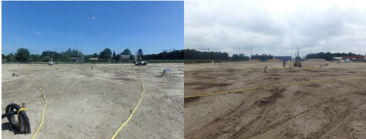
Figuur 3.11: uitvoeren directe injecties.
