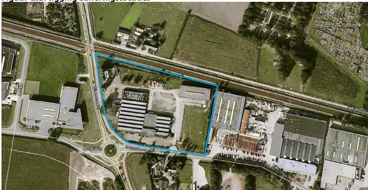
Figuur 2.1: ligging saneringslocatie.
