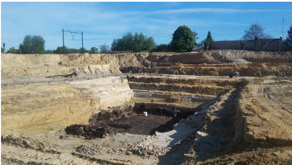
Figuur 3.6: ontgravingsput met op de putbodem de veenlaag.
