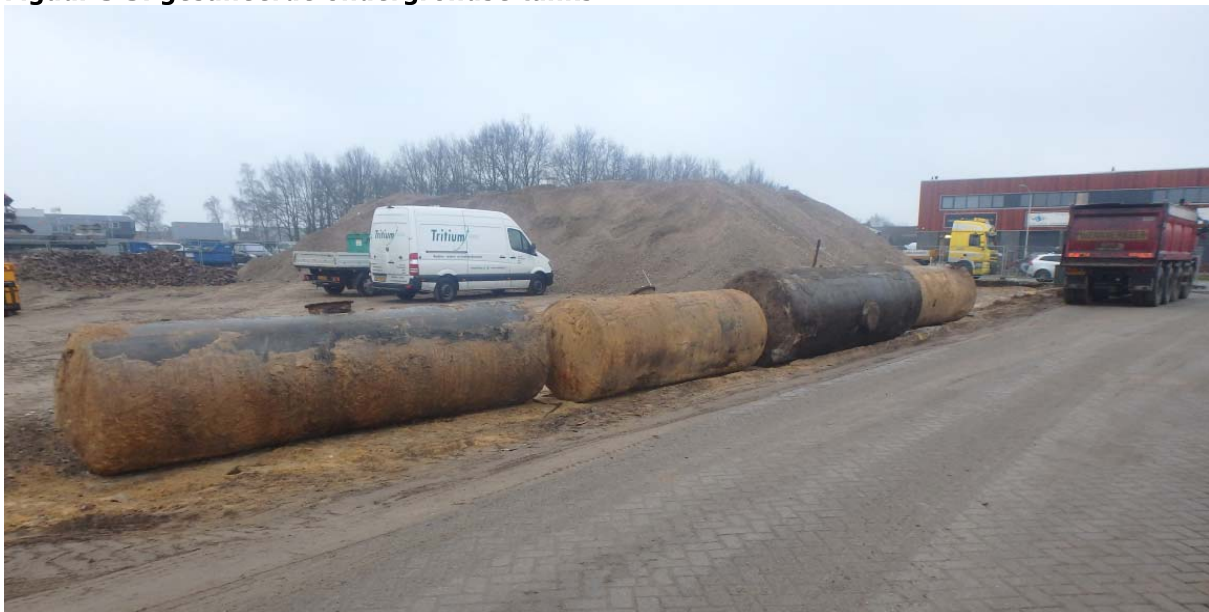
Figuur 3.3: gesaneerde ondergrondse tanks.
