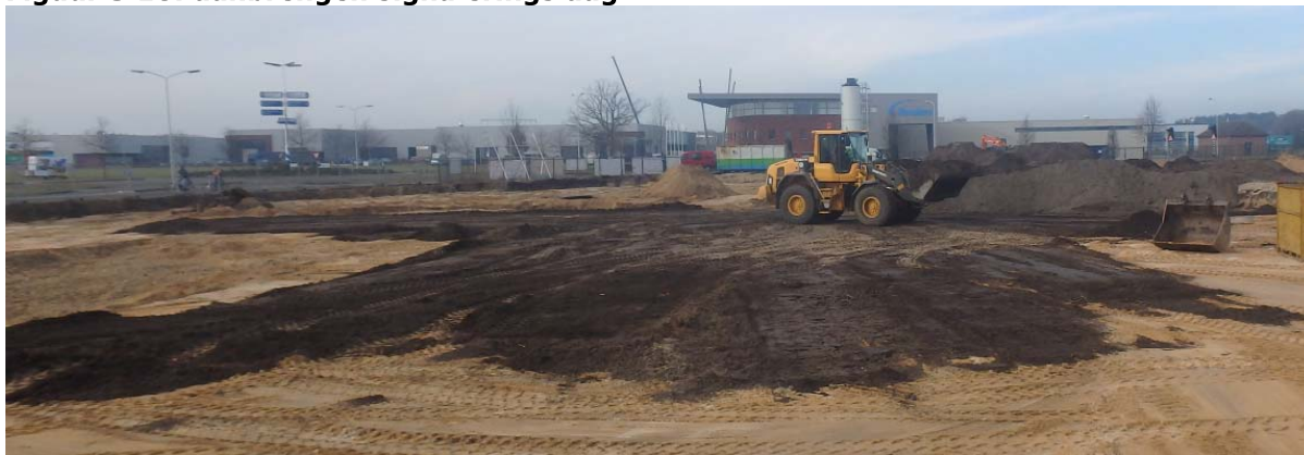
Figuur 3.10: aanbrengen signaleringslaag.
