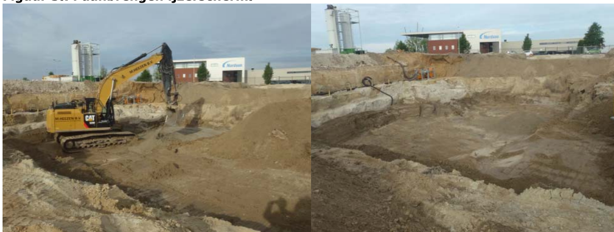
Figuur 3.7: aanbrengen ijzerschermb.
