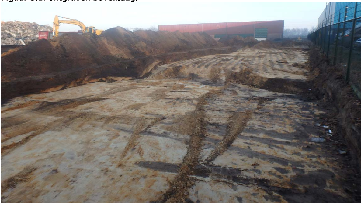
Figuur 3.1: ontgraven bovenlaag.
