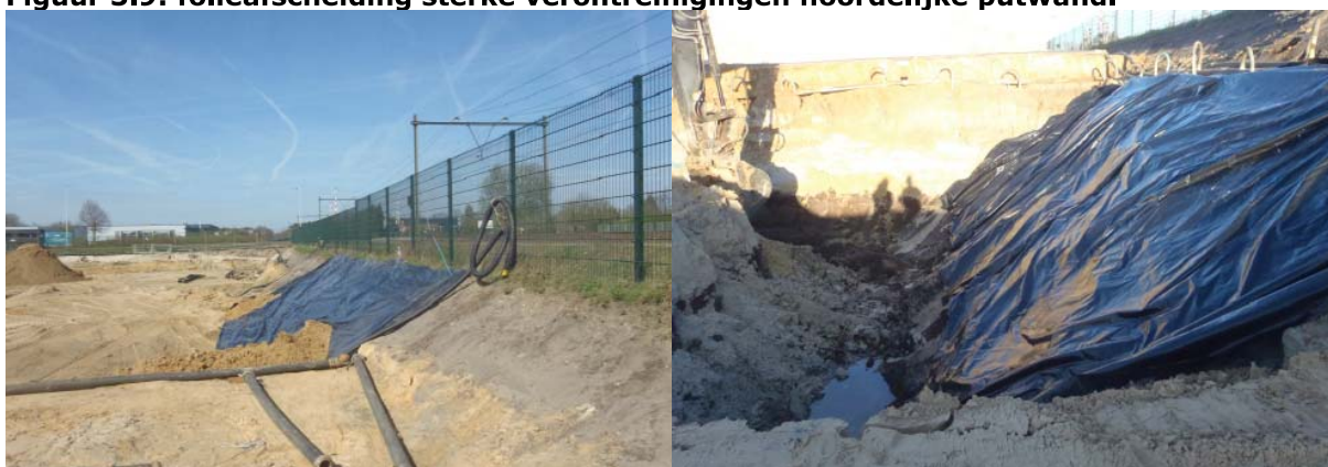
Figuur 3.9: folieafscheiding sterke verontreinigingen noordelijke putwand.
