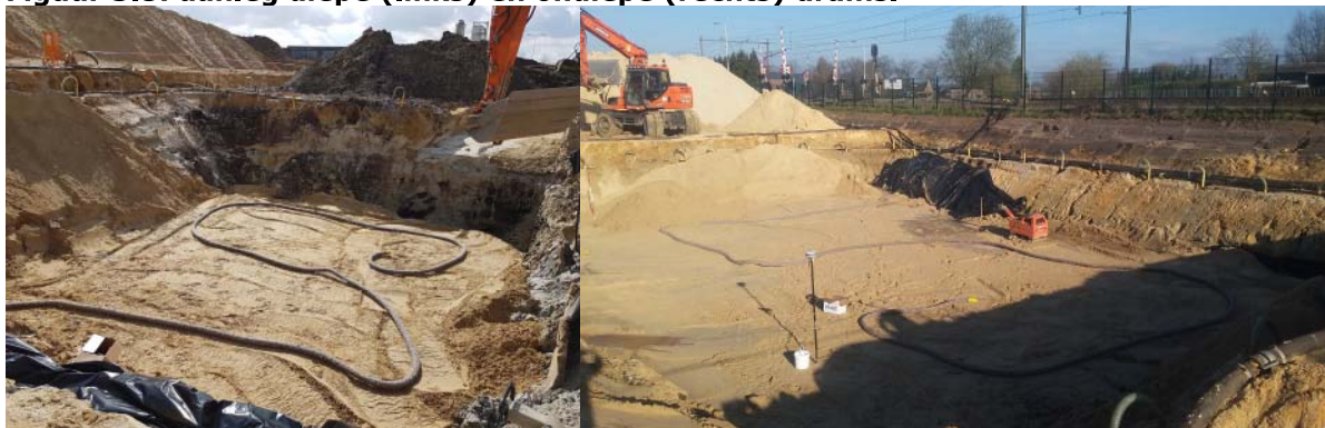
Figuur 3.8: aanleg diepe (links) en ondiepe (rechts) drains.
