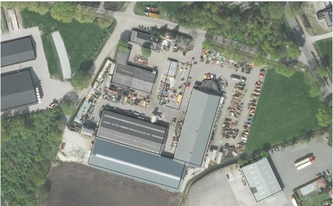
Figuur 1.1.1: Luchtfoto locatie Vestingweg 3 (bron: www.pdokviewer.pdok.nl ).
