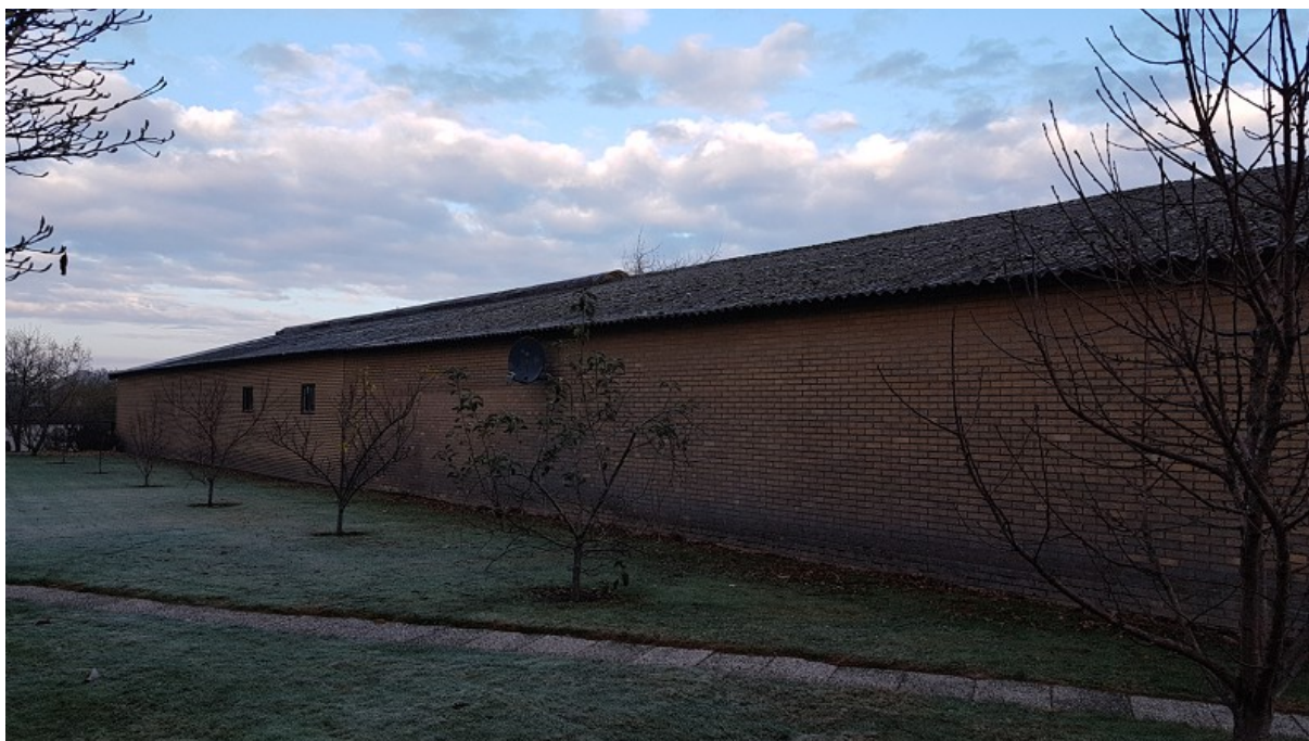
Zuidelijke gevel van de te slopen loods. Foto: B. Verhoeven | Ecoresult B.V.
