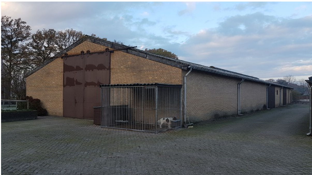
Oostelijke en noordelijke gevel van de te slopen loods. Foto: B. Verhoeven | Ecoresult B.V.
