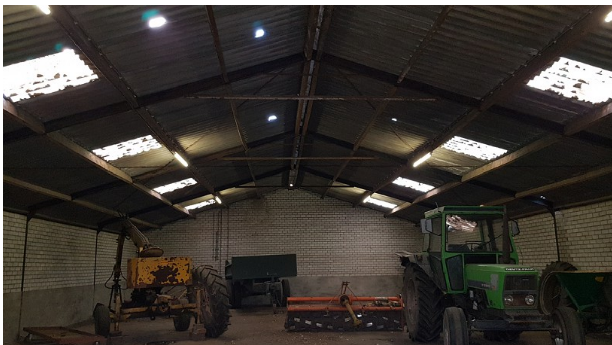
Binnenzijde van de te slopen loods. Foto: B. Verhoeven | Ecoresult B.V.
