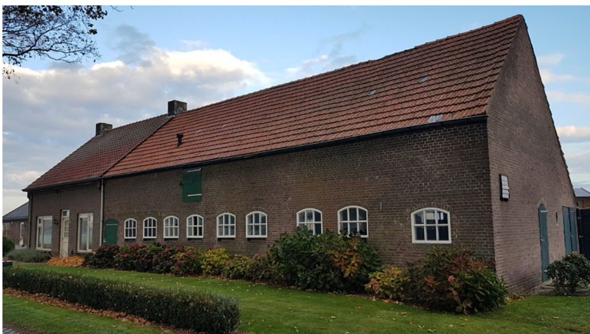
Zuidelijke gevel van de woonboerderij. Foto: B. Verhoeven | Ecoresult B.V.
