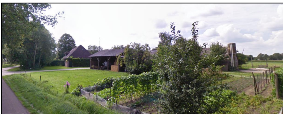
Afbeelding 4: Aanzicht bedrijfsbebouwing vanuit het zuidoosten (bron: Google Maps)
