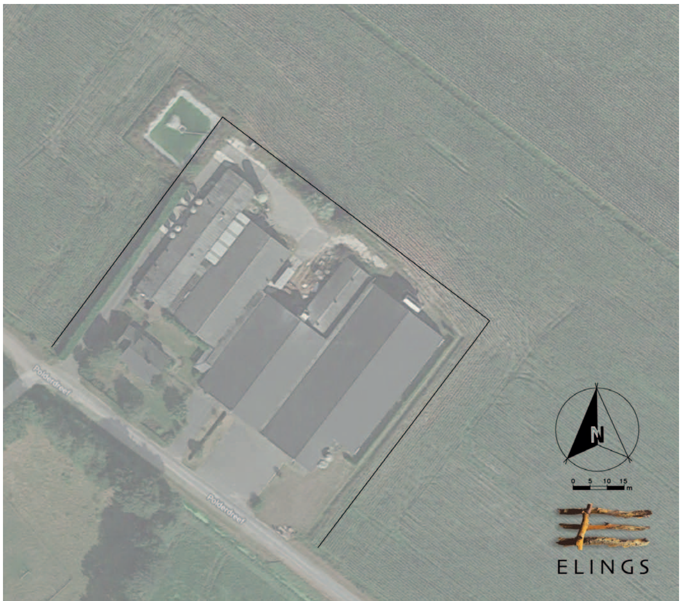
Figuur 2: Luchtfoto situatie perceel Polderdreef 5, Liessel (bron: Google Maps, 2018)
