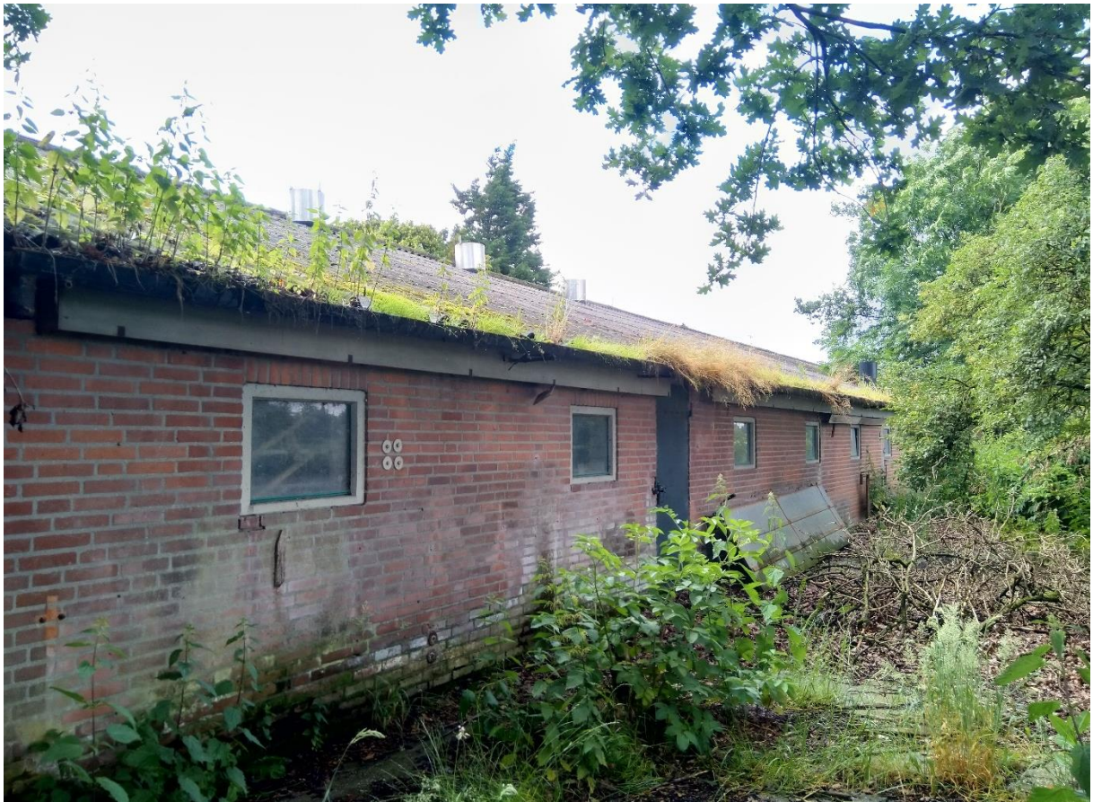
Foto 7: Impressie van de varkensstal kijkend naar de oostgevel.
