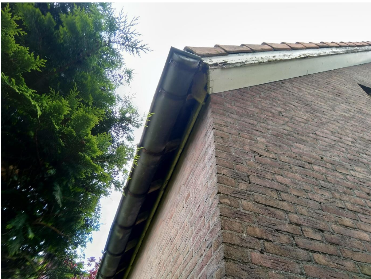
Foto 3: Impressie van de boeiboorden en overgang van de gevel naar het dak bij de bedrijfswoning.
