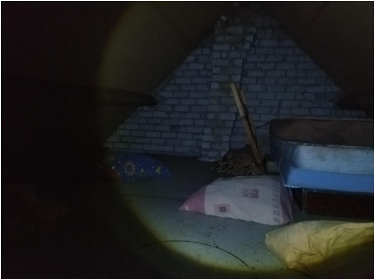
Foto 5: Impressie van de zolder in de bedrijfswoning.
