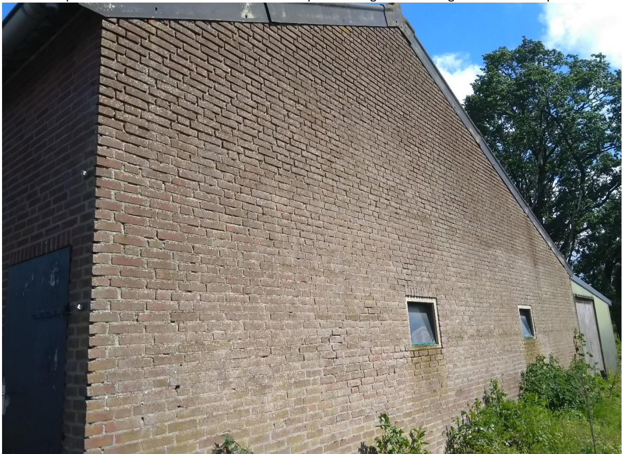
Foto 16: Impressie van de opslagschuur kijkend naar de westgevel.
