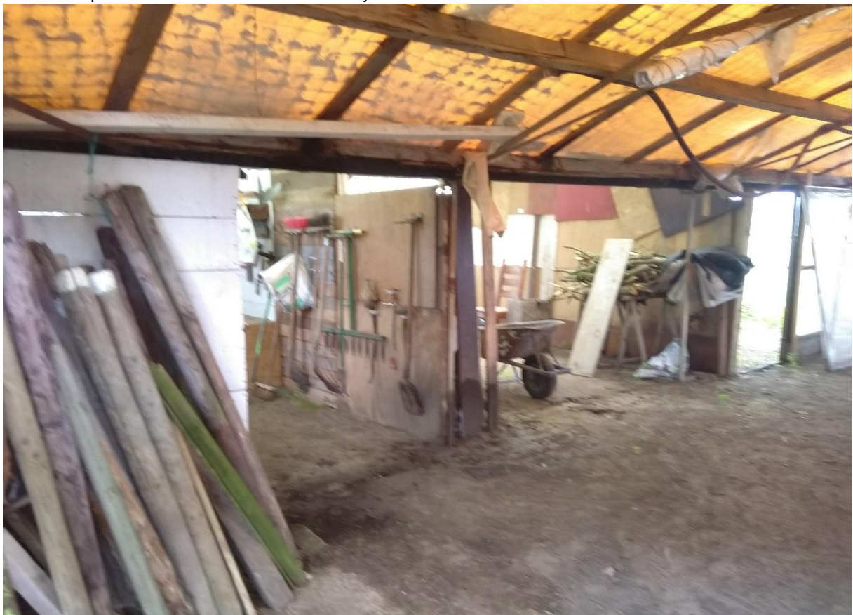
Foto 14: Impressie van de binnenzijde van de kas op de onderzoekslocatie.
