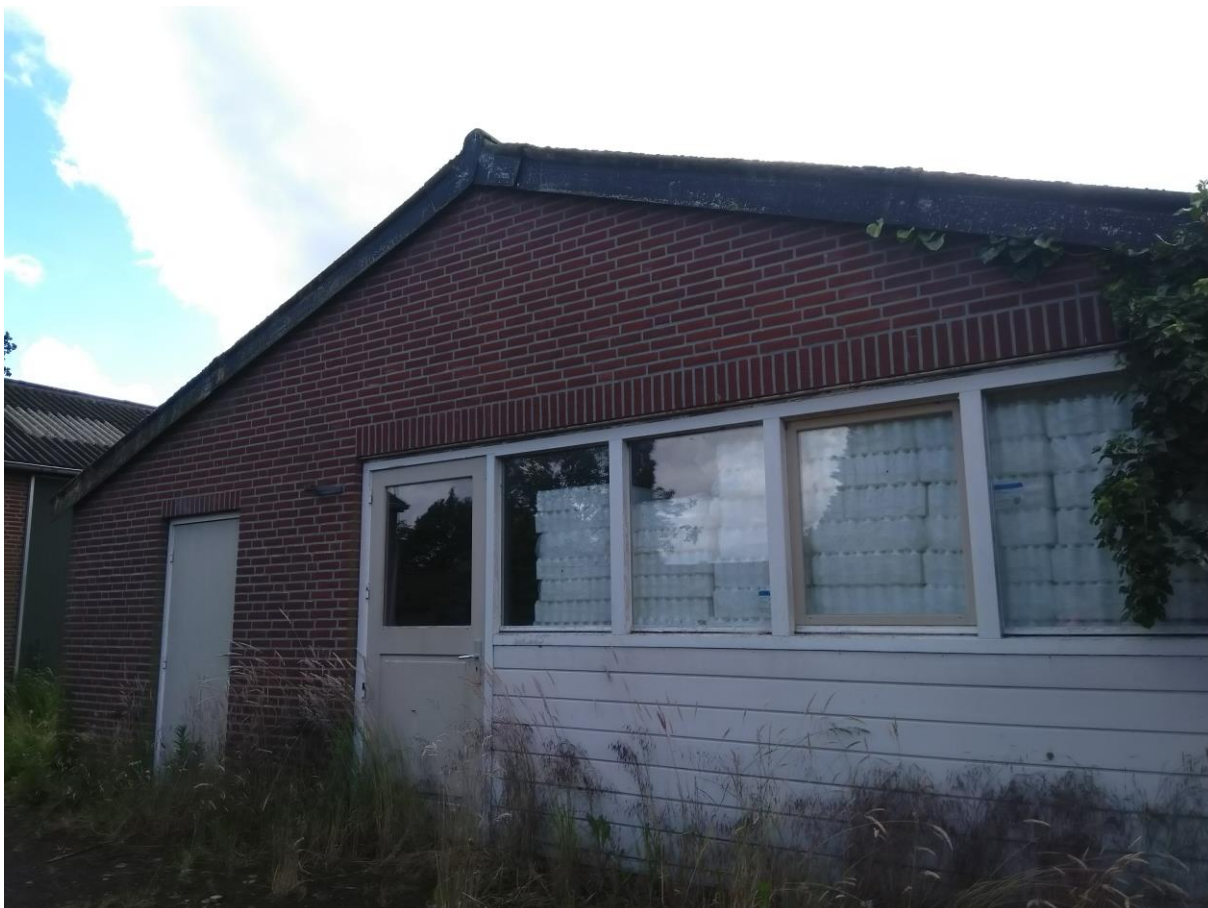
Foto 21: Impressie van het bijgebouw kijkend naar de oostgevel.
