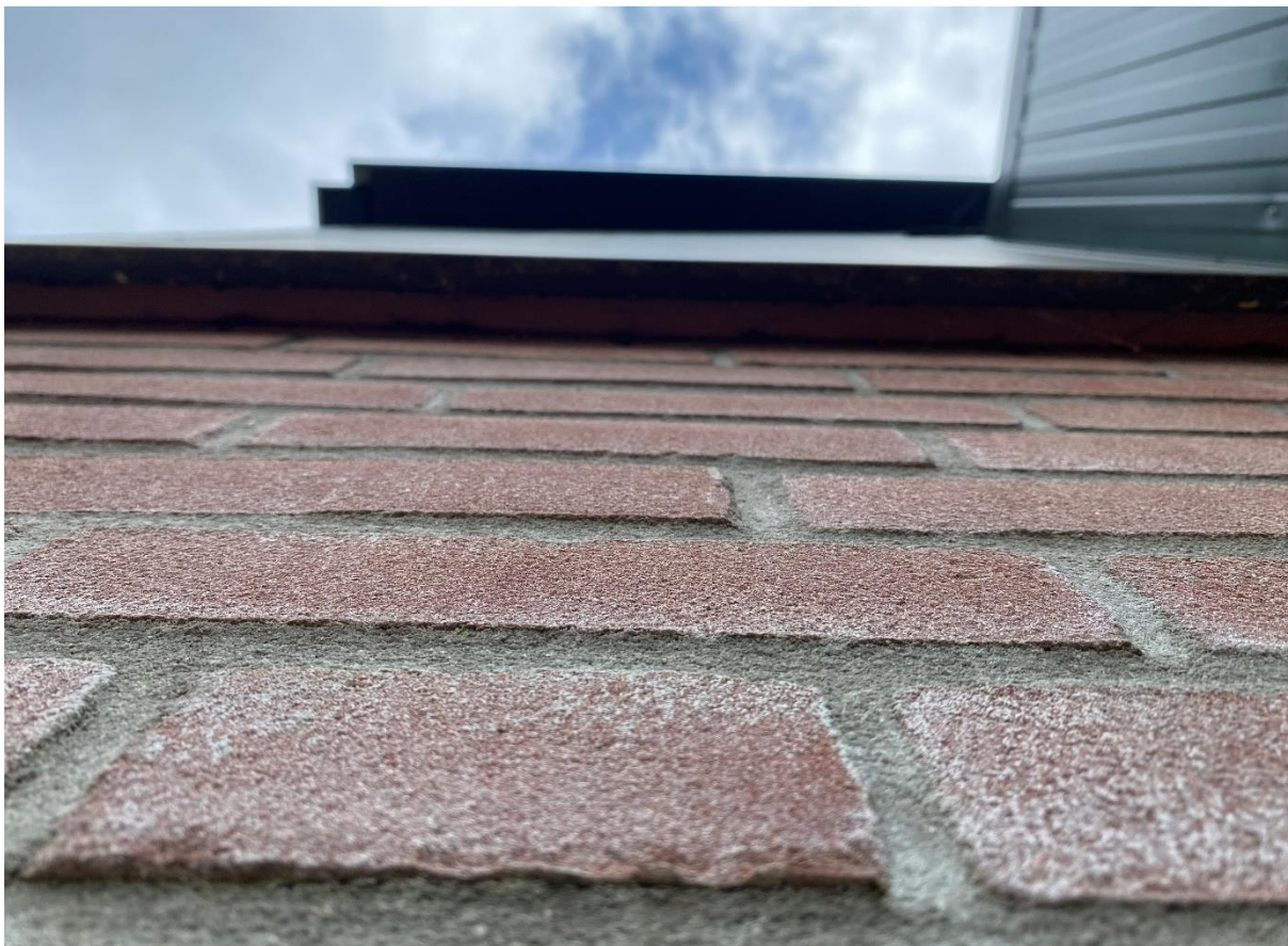
Foto 5: Impressie van de aansluiting van de gevelbekleding bij de werktuigenberging.
