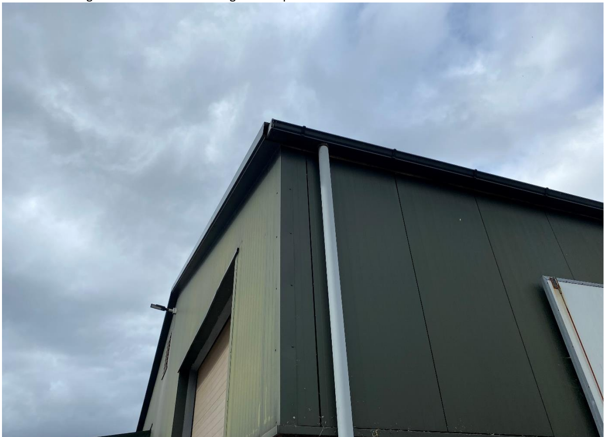
Foto 2: De kunststof gevelbekleding halverwege de gevels van het veeverzamelgebouw.
