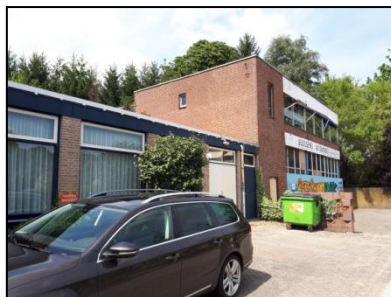
Figuur 7. Achterdeel woonhuis nr. 21 en voorzijde voormalig garagebedrijf.
