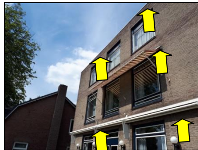
Figuur 15. Openingen onder de luifels die bevestigd zijn aan de woning
