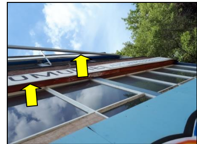
Figuur 16. Openingen onder de luifels die bevestigd zijn aan de voormalige garage en betimmering aan de voorgevel
