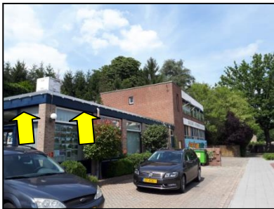
Figuur 14. Betimmering rondom het gehele dak
