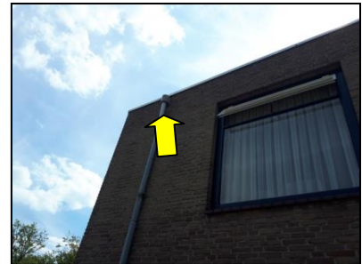
Figuur 13. Openingen achter de regenpijp
