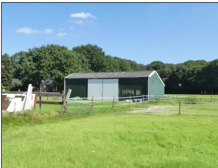
Figuur 5: Bedrijfsgebouw achterzijde perceel Hemelrijkseweg 14b
