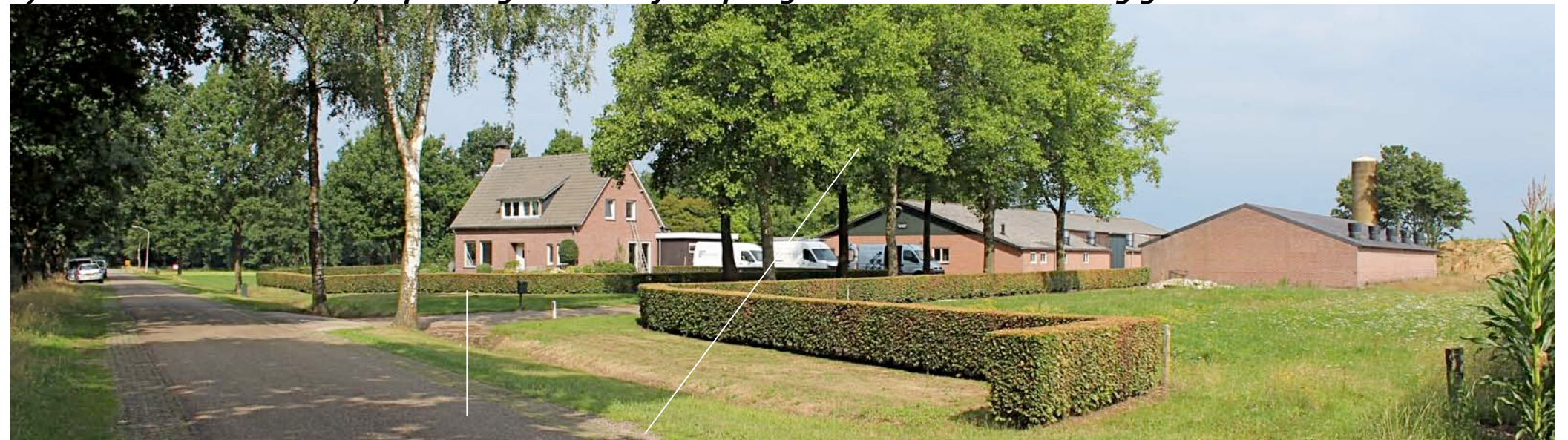
2) komend uit het oosten; de hagen en bomenrijen op het voorerf kleuren het beeld
