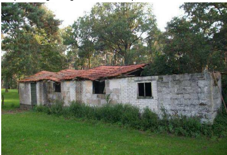
Figuur: foto voormalig agrarisch bijgebouw (Bron: gemeente Deurne, 2011)
