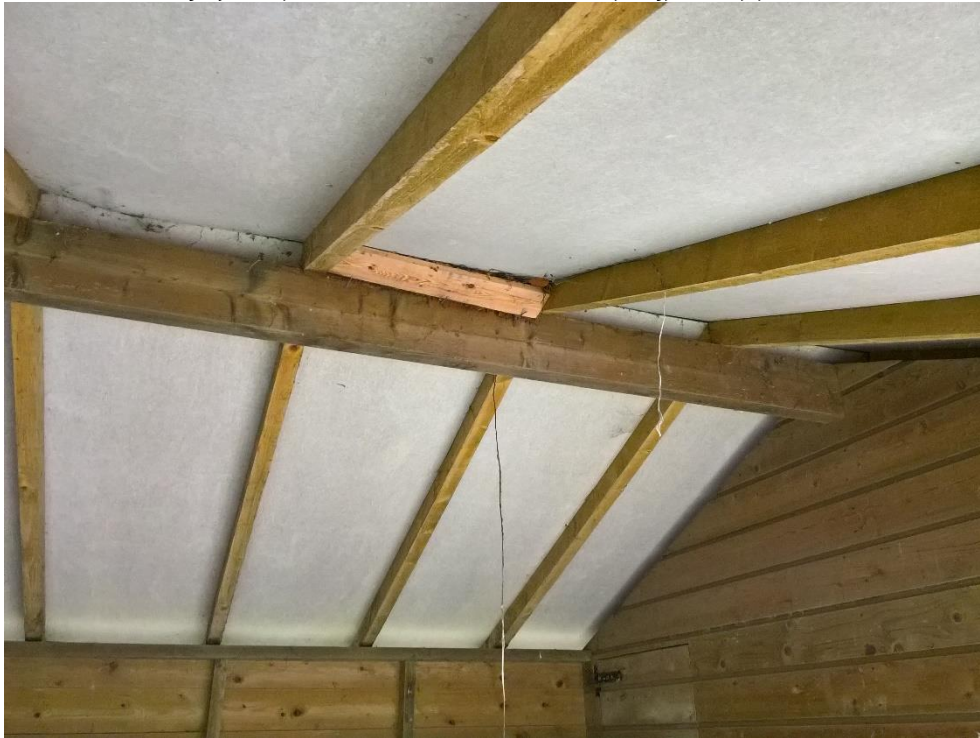
Foto 7. Mogelijk nestplaats voor in de nok van de houtopslagplaats op perceel 2105
