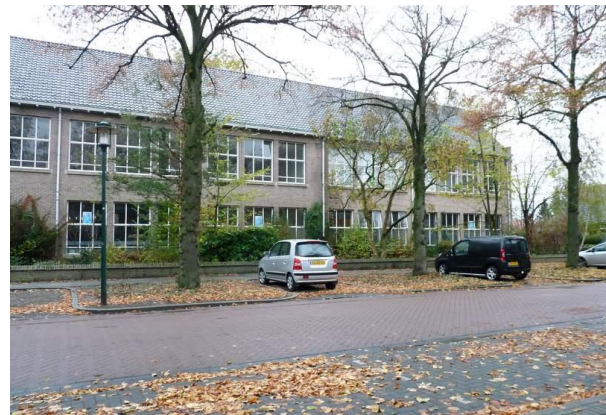
Figuur 10. Zuidzijde van schoolgebouw 2, gezien vanaf de Kruisstraat.
