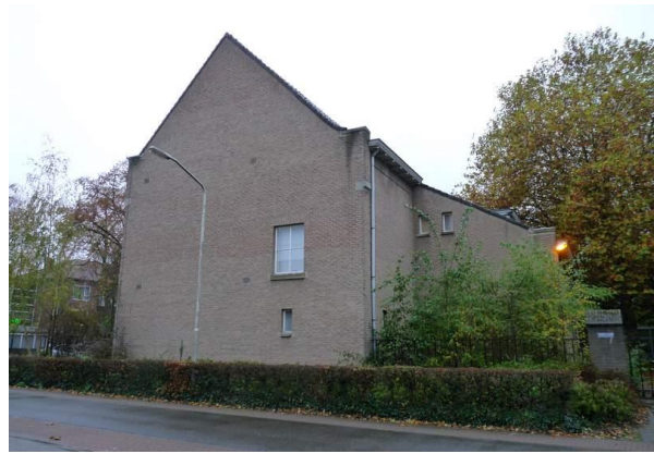
Figuur 12. Zijaanzicht van schoolgebouw 2, gezien vanaf de Flemingstraat. Foto genomen in oostelijke richting.
