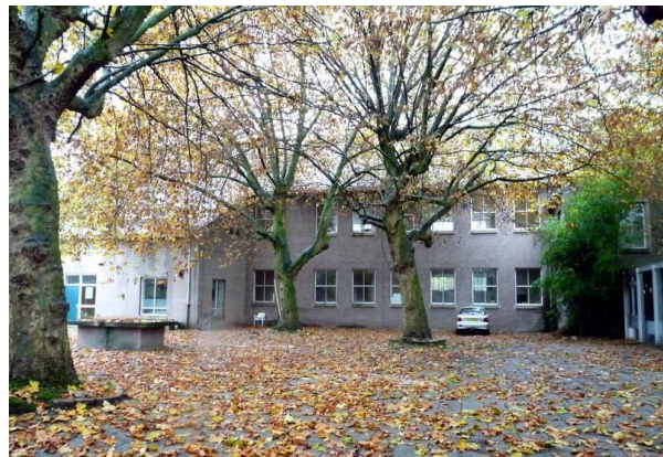
Figuur 14. Zicht op de achterzijde van schoolgebouw 2, gezien vanaf het binnenpleintje. Foto genomen in zuidelijke richting
