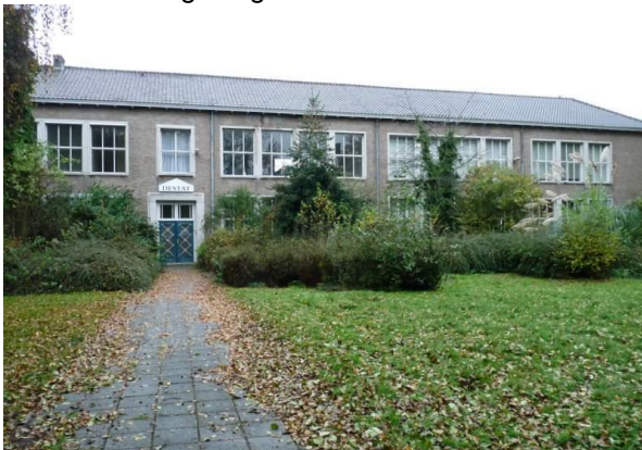
Figuur 3: Overzicht westkant schoolgebouw 1, gezien vanaf de Kruisstraat. Foto genomen in noordelijke richting.
