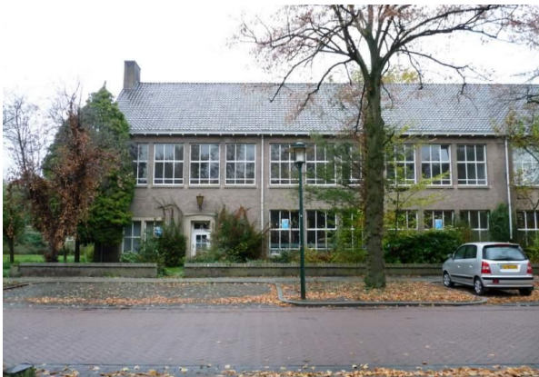
Figuur 9. Zuidzijde van schoolgebouw 2, gezien vanaf de Kruisstraat.
