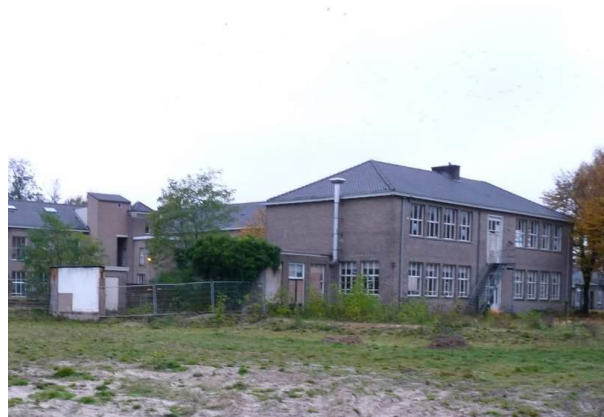
Figuur 18. De meest oostelijke vleugel van schoolgebouw 1 en de twee kleine bijgebouwtjes. Foto genomen in zuidwestelijke richting.
