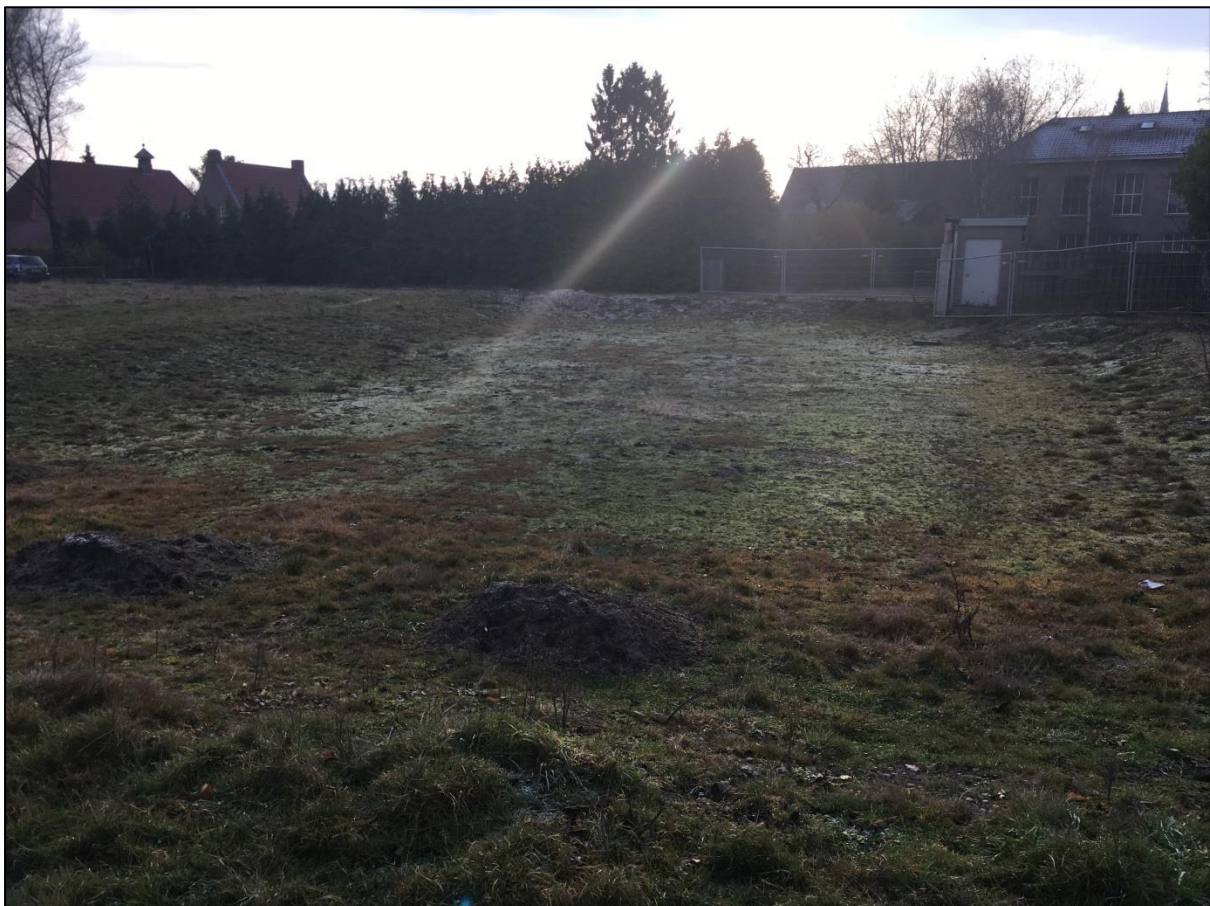
Foto 1: slooppot gesloopt schoolgebouw
