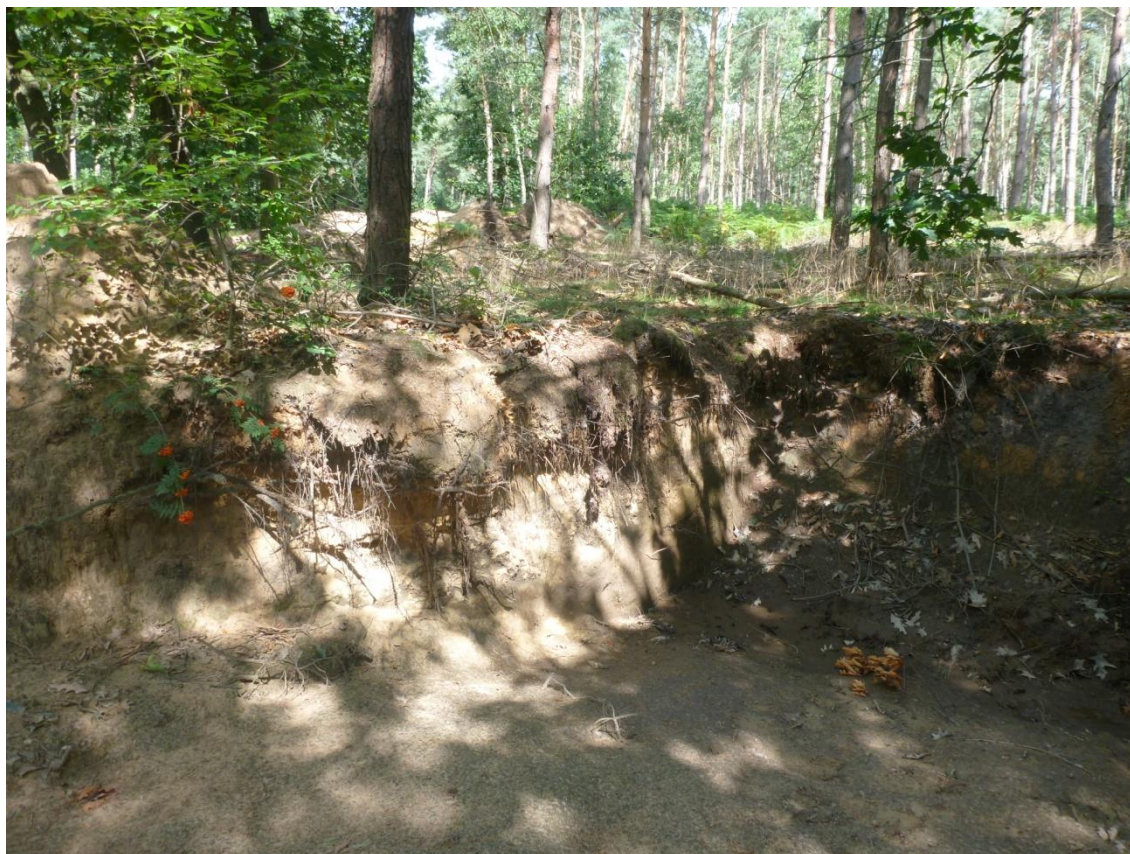
Fig. 3.1: Locatie profielkolomwand/boring 43 net buiten het plangebied. Op de foto staat het aangezicht van de noordwand.
