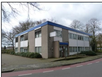
Figuur 5. Kantoorpand aan de Tramstraat.
