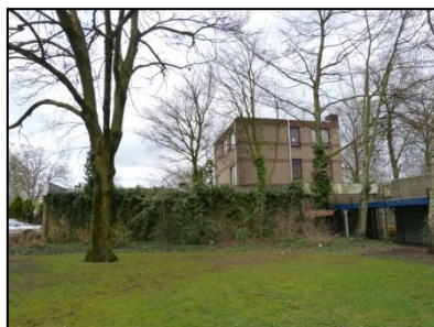
Figuur 6. Achterzijde bebouwing.
