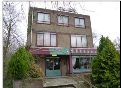
Figuur 5. Entree voormalig hotel-restaurant.
