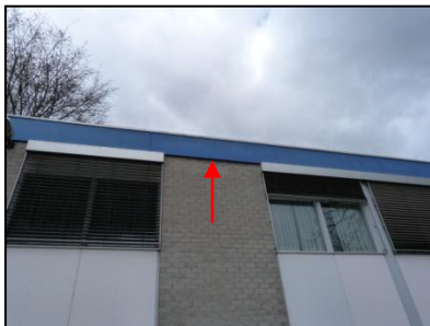
Figuur 12. Ruimte achter dakrand.
