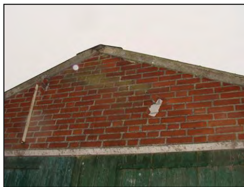
Foto 7. Toegang tot spouwmuur van schuur
