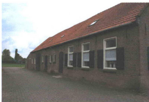
Linkerzijgevel vanaf de voorzijde
