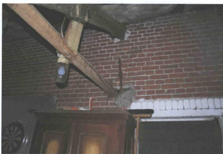
Oorspronkelijke buitenmuur in de uitbouw
