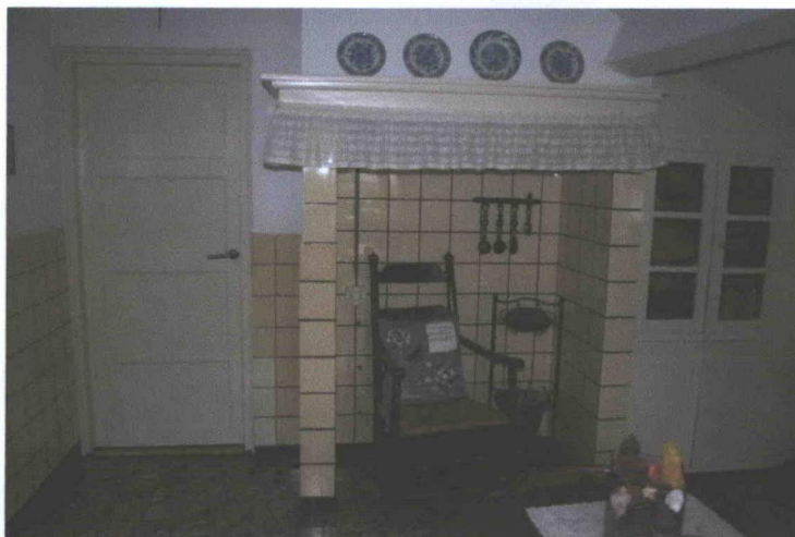
Betegelde ruimte in de uitbouw
