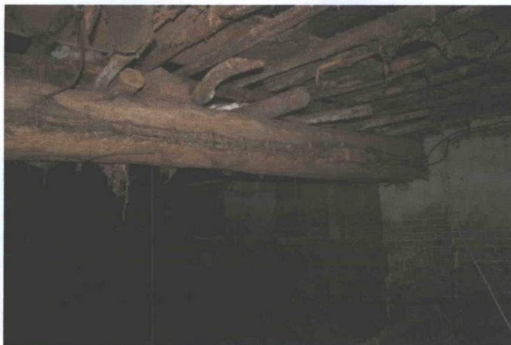
Houten balk met rondhouten zoldering
