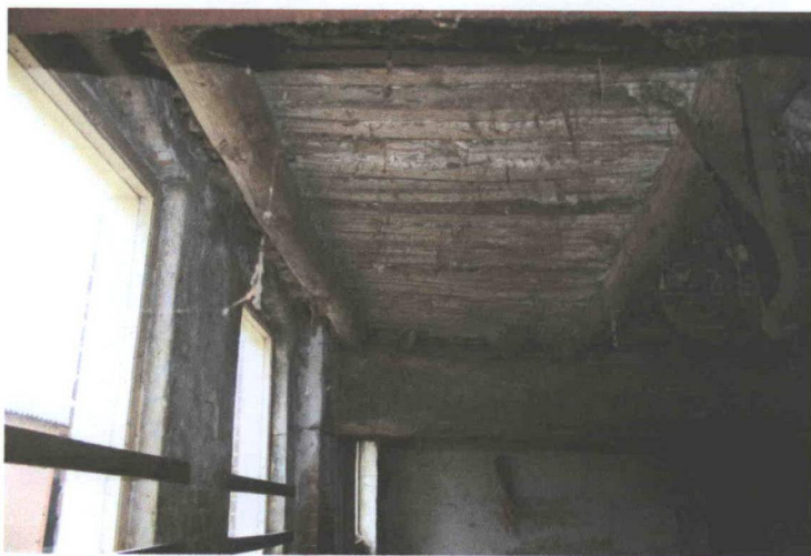
Houten balk met zoldering van rondhout
