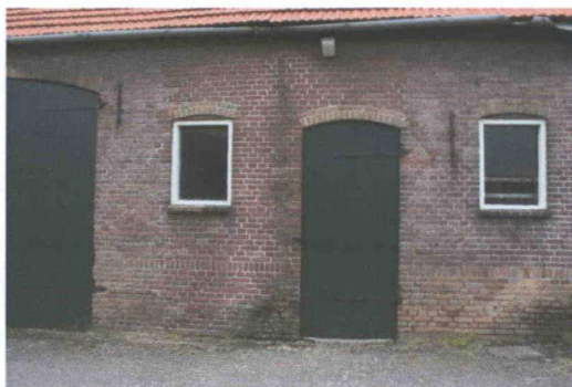
Stalraam en loopdeer op de plaats van de potstaldeer
