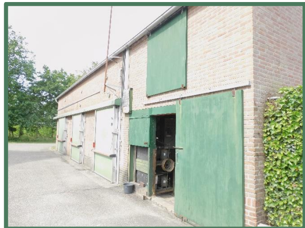
Te slopen koelcellen en werkplaats vanaf noordwest
