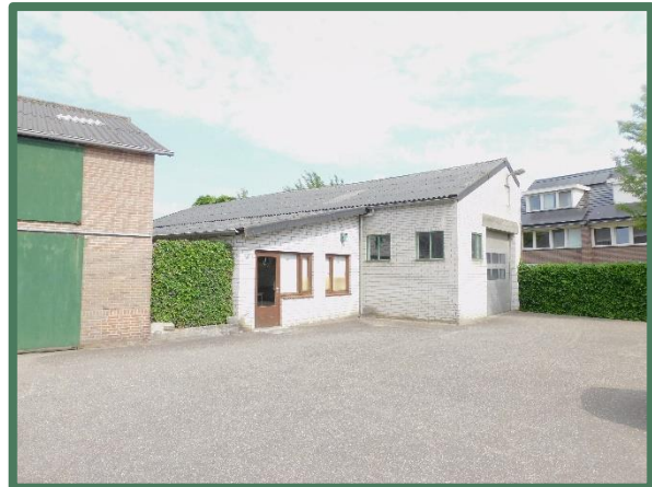
Te slopen winkel en opslag vanaf zuidwest
