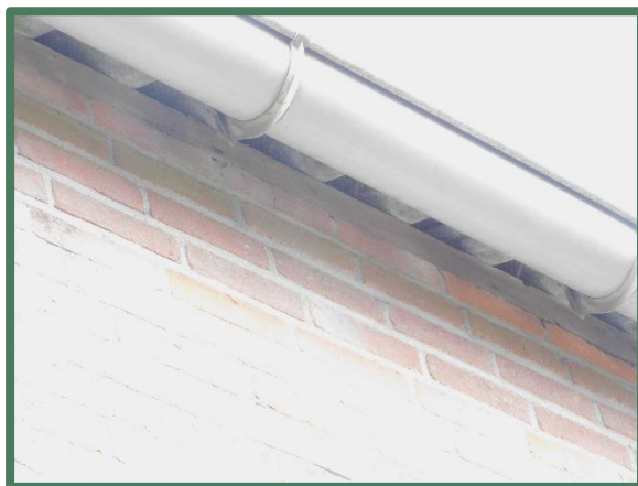
Openingen onder dak boven muurplaat buiten
