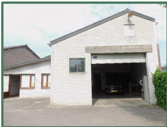
Te slopen winkel en opslag van west in tuin nummer 16b
