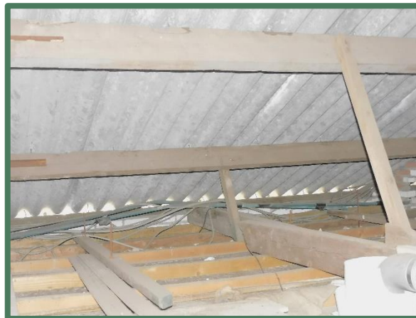
Openingen onder dak boven muurplaat binnen
