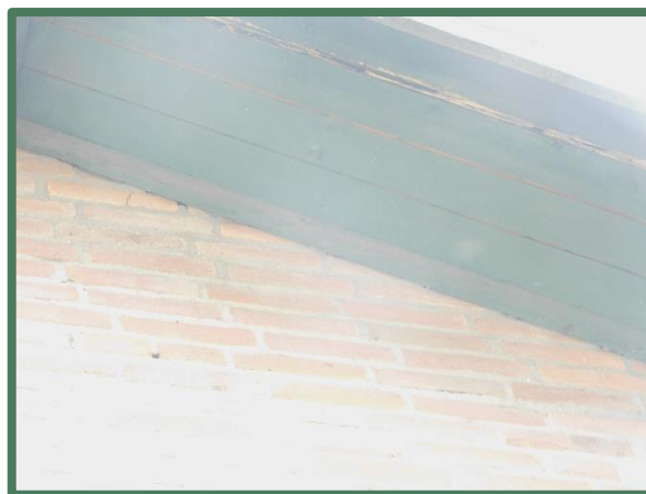
Aansluitende overstek koelcellen
