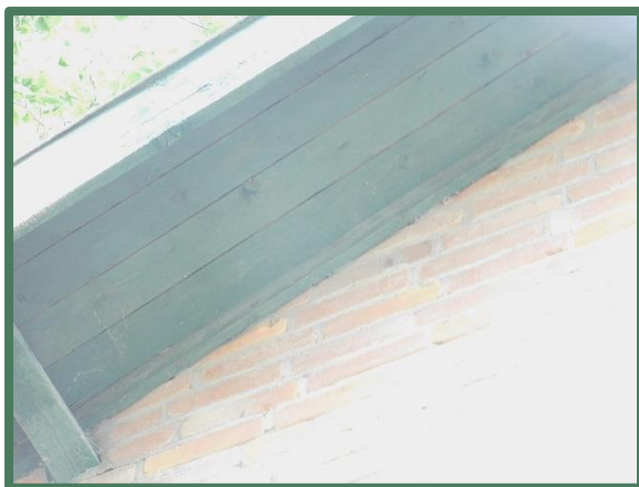
Aansluitende overstek koelcellen
