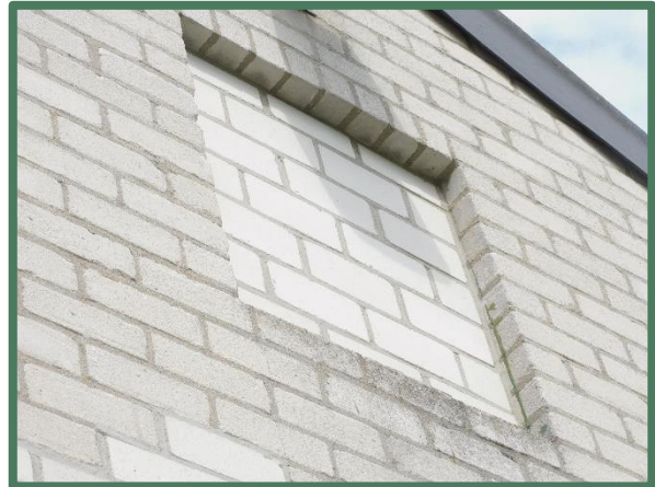
Afgesloten gevel en windveer met panlat
