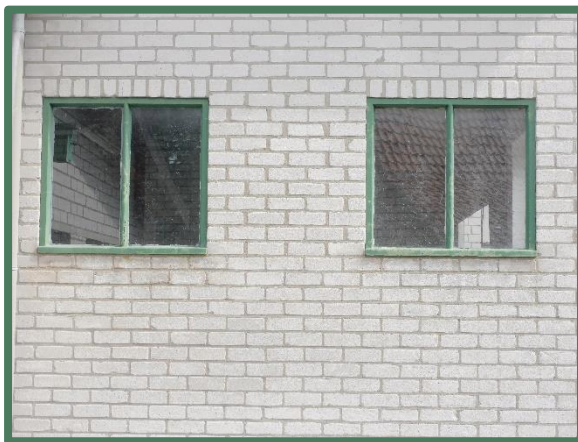
Strak aansluitende kozijnen in een dichte muur
