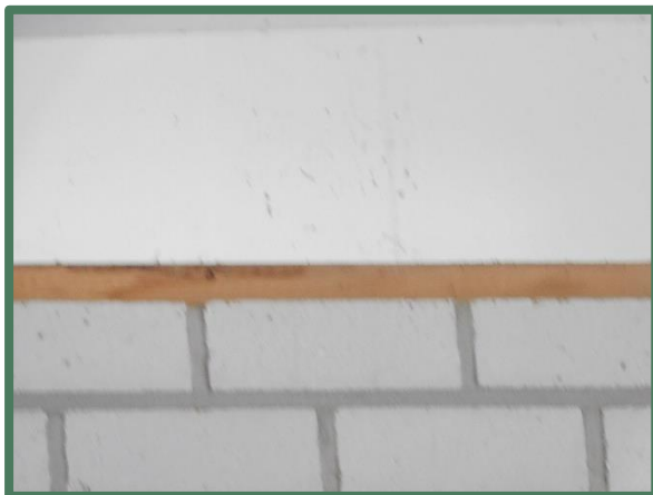
Afgesloten spouw meest noordelijke muur
