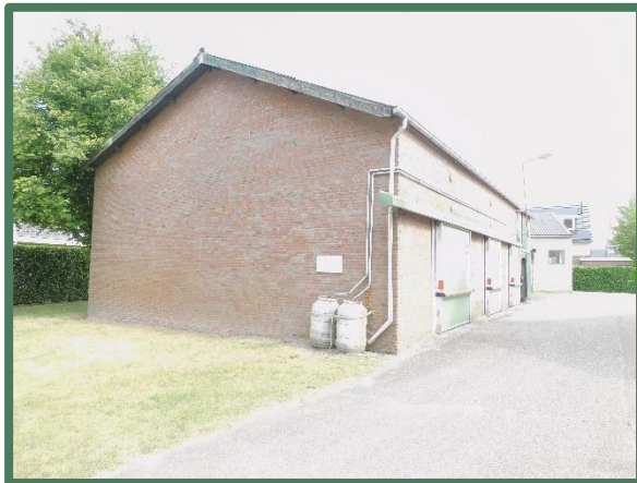
Te slopen gebouwen vanaf zuid
