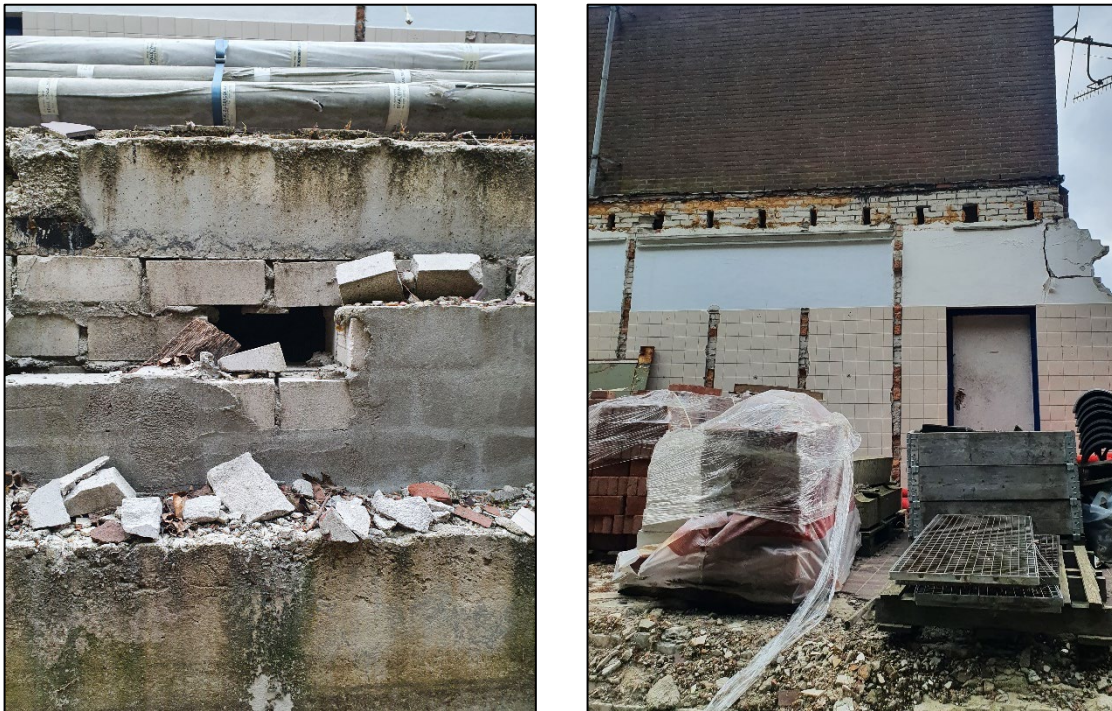
Figuur 8: Overzicht van gaten die toegang geven tot de kruipruimte en de puinhopen die dekking kunnen geven voor marterachtigen.
