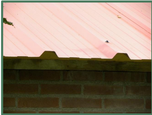
Foto 19: Mogelijk te slopen aanbouw gesloten met een muurplaat.
