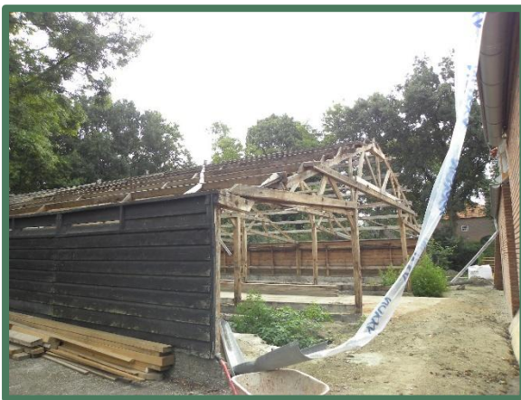
Foto 5: Overzicht te slopen stal vanaf het noorden.
