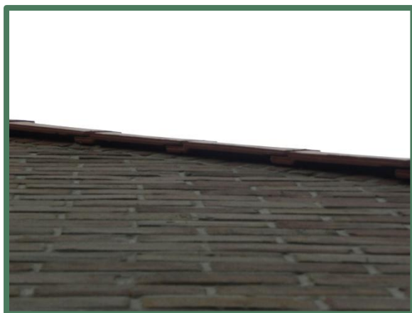
Foto 25: Noordelijke kantpannen van de woning geopend.
