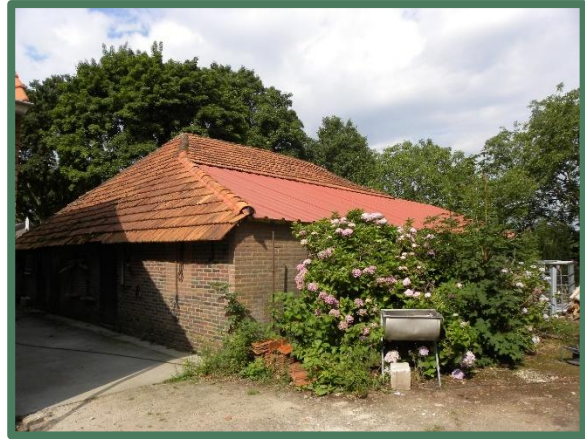
Foto 4: Overzicht schuur oostelijke aanbouw.
