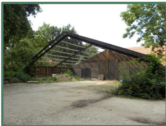
Foto 1: Overzicht te slopen stal.
