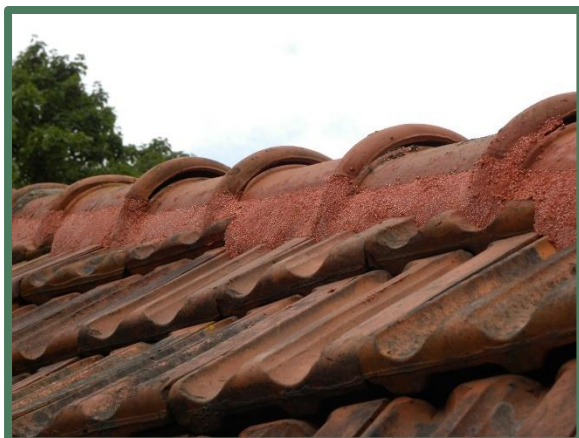
Foto 23: Nokpannen van de schuur gesloten.
