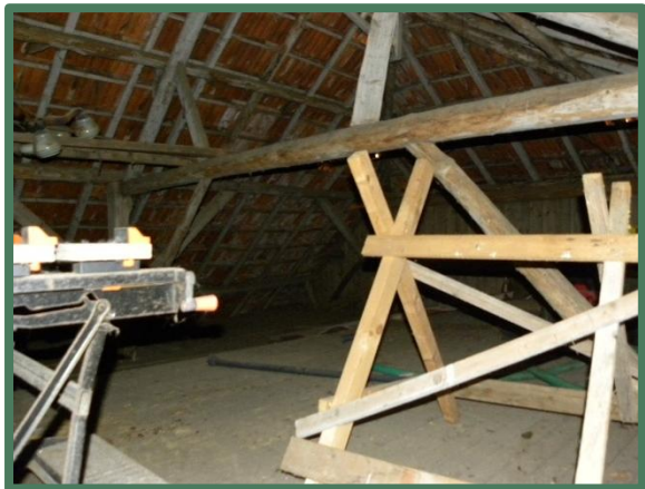
Foto 21: Overzicht op de zolder van de schuur, geen sporen.
