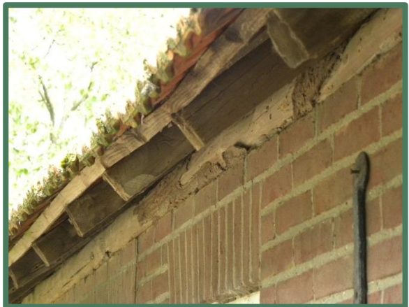
Foto 22: Westzijde van de schuur tevens gesloten.
