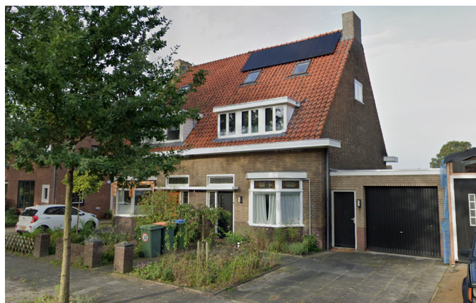
Voorbeeldwoning aan de Moleneindstraat met erkers
