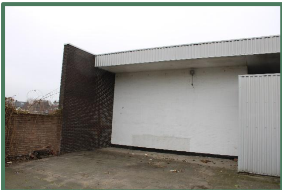
Foto 5 + 6: Open stootvoegen in westzijde voormalige autogarage.
