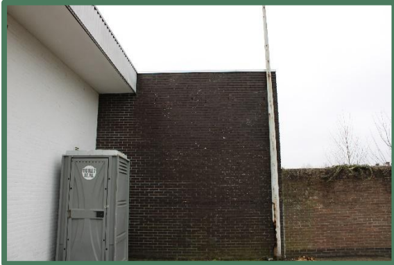
Foto 1 + 2: Open stootvoegen in oostzijde voormalige autogarage.
