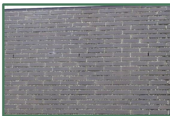
Foto 19 + 20: Open stootvoegen in noordzijde voormalige autogarage.
