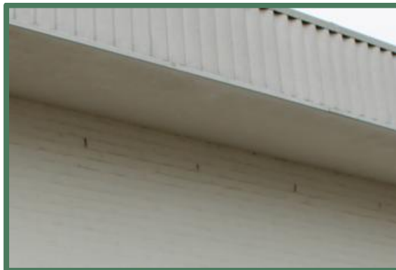
Foto 15 + 16: Open stootvoegen in oostzijde voormalige autogarage.
