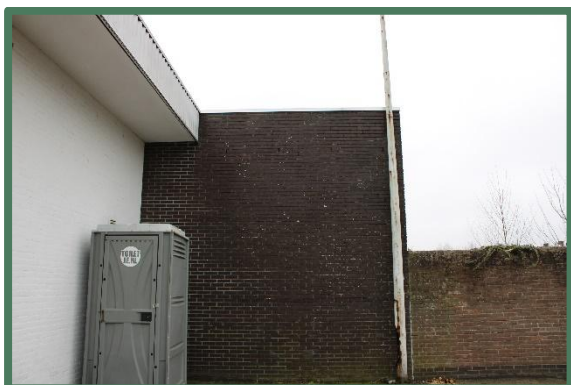
Foto 13 + 14: Open stootvoegen in oostzijde voormalige autogarage.
