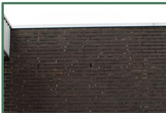
Foto 13 + 14: Open stootvoegen in oostzijde voormalige autogarage.
