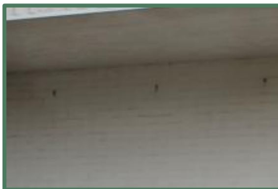
Foto 17 + 18: Open stootvoegen in westzijde voormalige autogarage.
