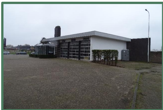
Foto 1: Voormalige autogarage, vanaf het zuidoosten.
