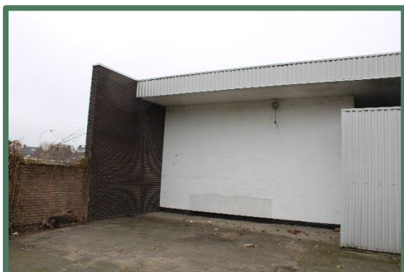
Foto 17 + 18: Open stootvoegen in westzijde voormalige autogarage.
