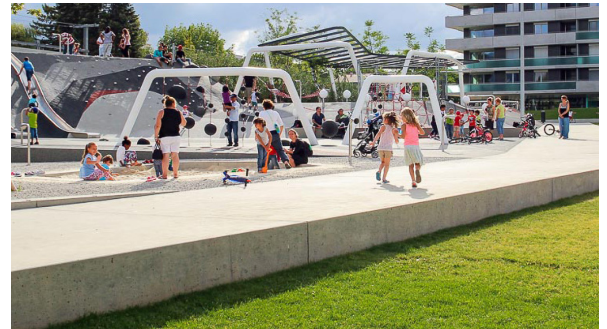
Betonrand (50cm zicht/hoog, >70cm breed)
