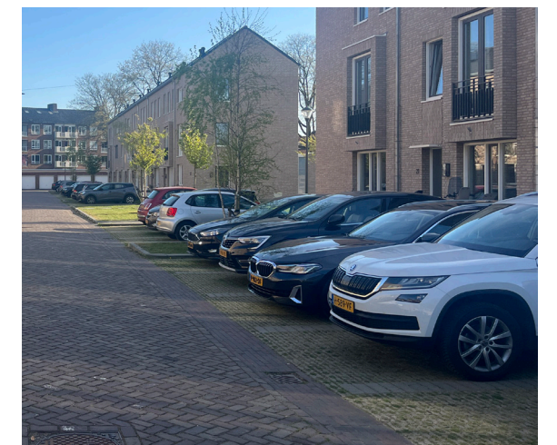
Straatbaksteen (KF) als rijbaan, NCB (gras)stenen als parkeerplaats
