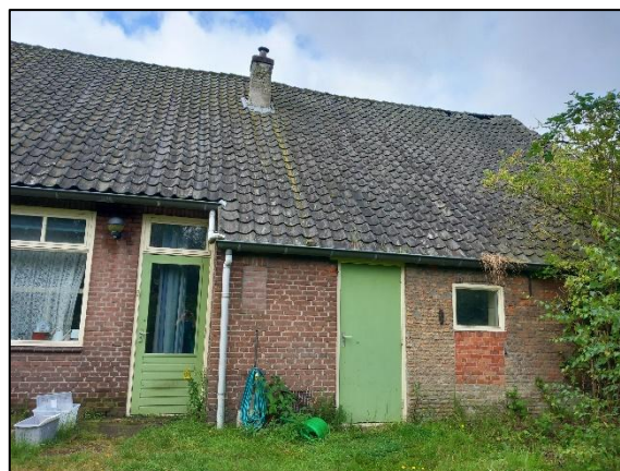
Foto D: Noordzijde gebouw (W)
