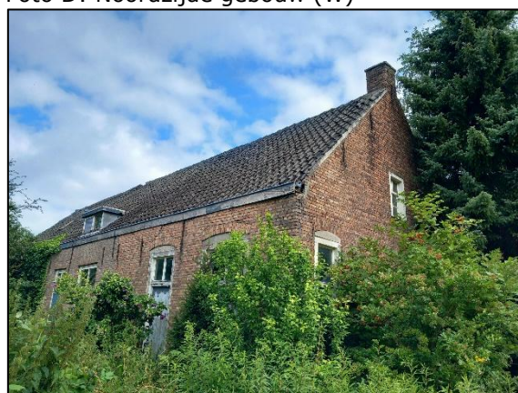
Foto F: Zuidzijde gebouw
