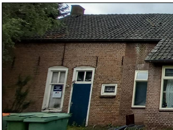
Foto C: Noordzijde te slopen gebouw (O)
