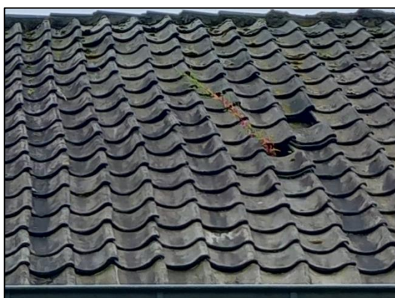
Foto A: ruimte onder dakpannen noordzijde
