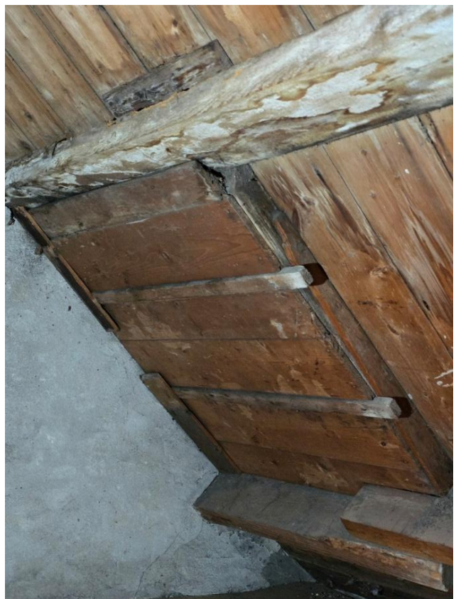
Op de onderzijde van de muurplaats is de aftekening te zien van de in 1938 gesloopte achtergevel. Het muurtje dat we nu zien, is in 1938 opgetrokken bovenop een in dat jaar aangebrachte stalen balk waarin de enkelvoudige balklaag van de zoldervloer werd opgelegd. De rechterfoto toont vermoedelijk de dichtzetting van de doorgang voor het rookkanaal van de in 1938 gesloopte inpandige oven.
