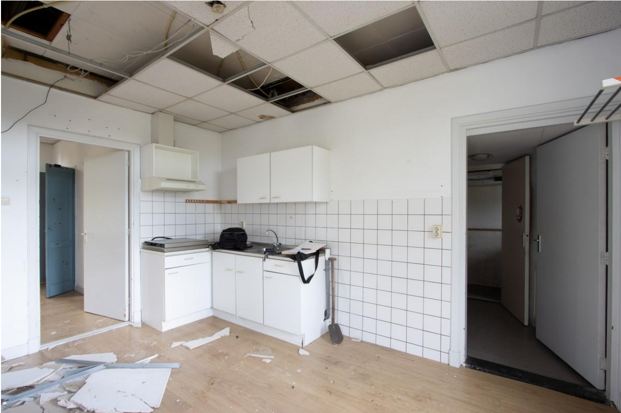
De keuken gezien in de richting van het bedrijfsgedeelte. De deuropening rechts is in 1938 gemaakt. Een eerdere deuropening heeft in de hoek gezeten waar zich thans het keukenblokje bevindt. Boven het systeemplafond een vast softboardplafond, vermoedelijk uit 1938.
