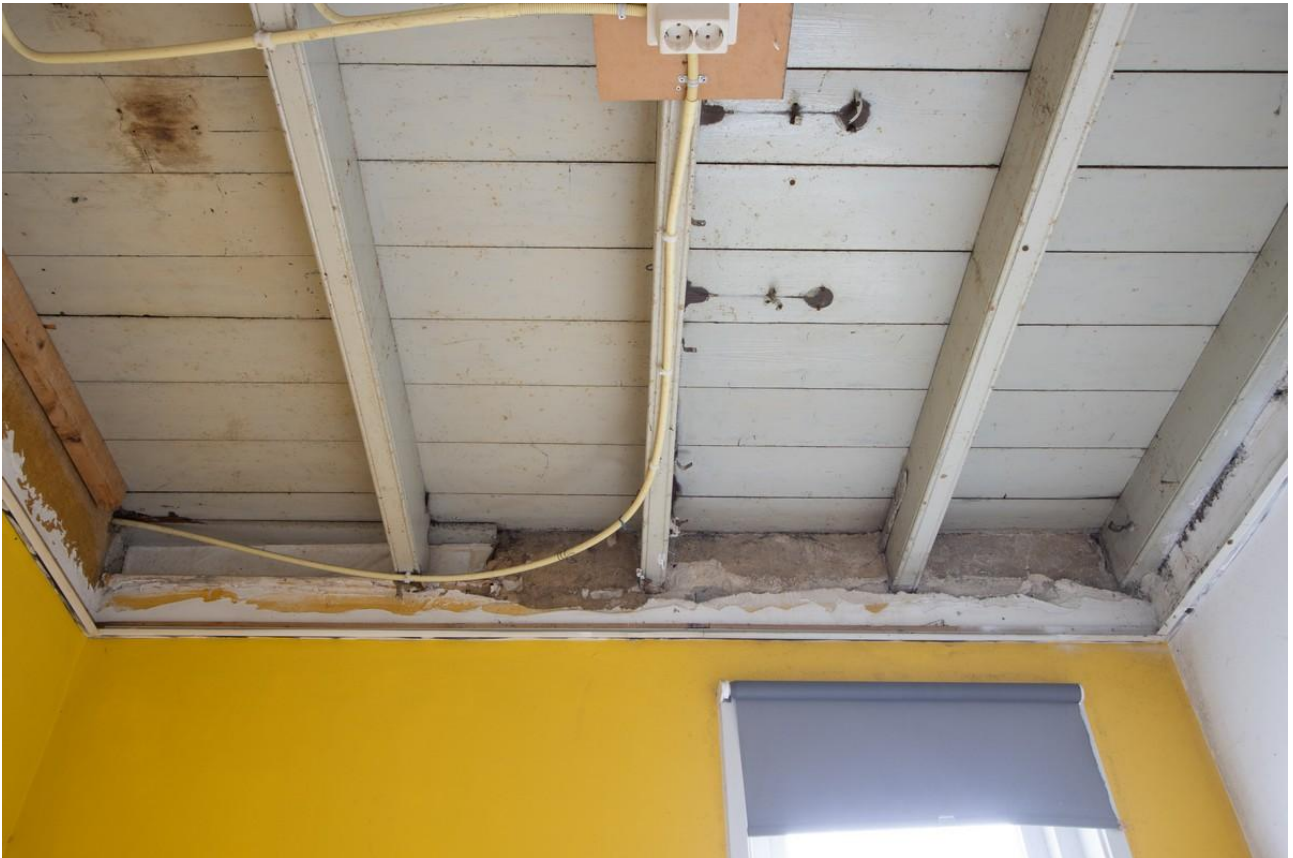
In de achtergevel is de stalen balk te zien die in 1938 werd gemaakt om de uitbreiding van de keuken mogelijk te maken.
