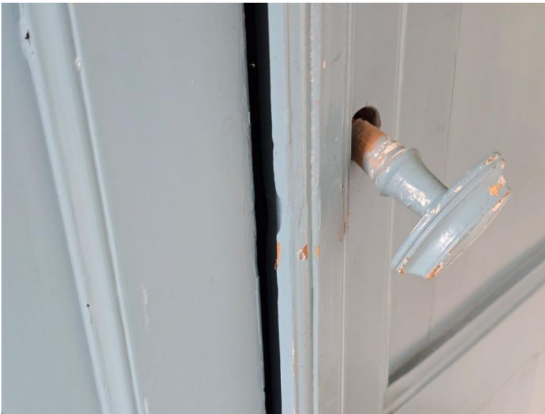
Kruk en details van de bedstede deur wijzen er op dat de deuren uit de bouwtijd zijn, en in de niet-oorspronkelijke wand zijn hergebruikt op het moment dat in de bedsteden de zoldertrap kwam.
