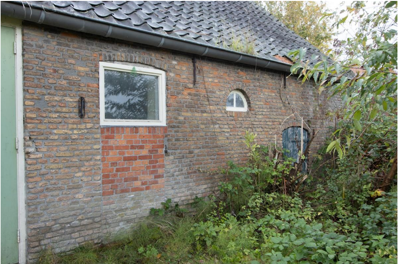
De achtergevel van het bedrijfsgedeelte met rechts twee van oudsher aanwezige gevelopeningen, één met een deurtje de ander met een in hout uitgevoerd stalraam.
