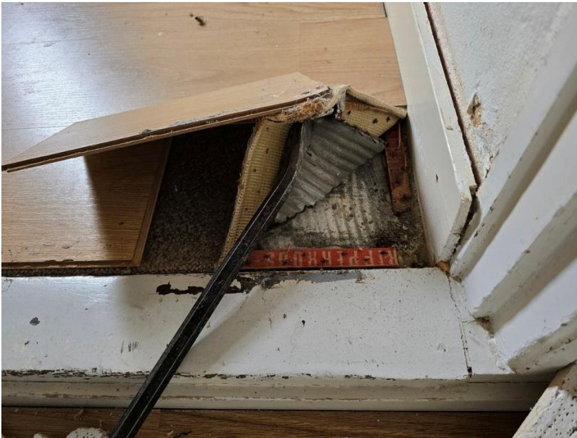
Betonvloer in de slaapkamer. De vloer is in de plaats gekomen van een hoger gesitueerde opkamervloer, vermoedelijk zoals thans nog aanwezig in het buurpand. Rechts opname van de slaapkamer richting de achtergevel.
