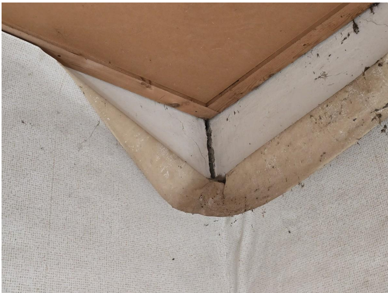
Opname gemaakt in de bedstede, waar we kunnen zien dat de scheidingswand tussen de bedsteden koud tegen de oudere rechterzijgevel van het buurpand is aangezet. Behangsels uit omstreeks 1960.
