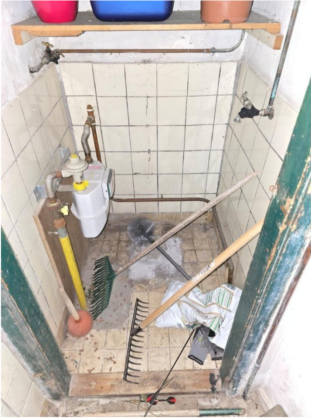
De wandtegels in de voormalige plee. De afwerkingen van vloer en wand (tegelwerk) zijn vermoedelijk van ná 1938 (XX-c).
