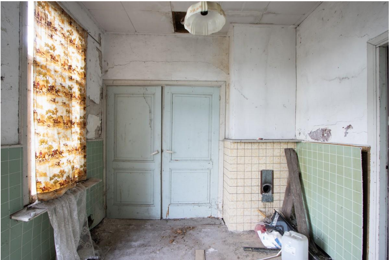
De wand met opkamer- en kelderdeur, beide uit de bouwtijd van het pand.
