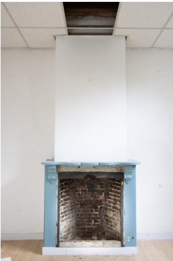
De haardpartij met houten mantel. Beroeting wijst op een open vuur. Rechts detail van één van de consoles in neostijl.
