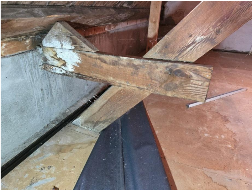
Detail van de aansluiting van het blokkeel op het spantbeen. Rechts de op afstand geplaatste gording ter plaatse van de dakkapel.
