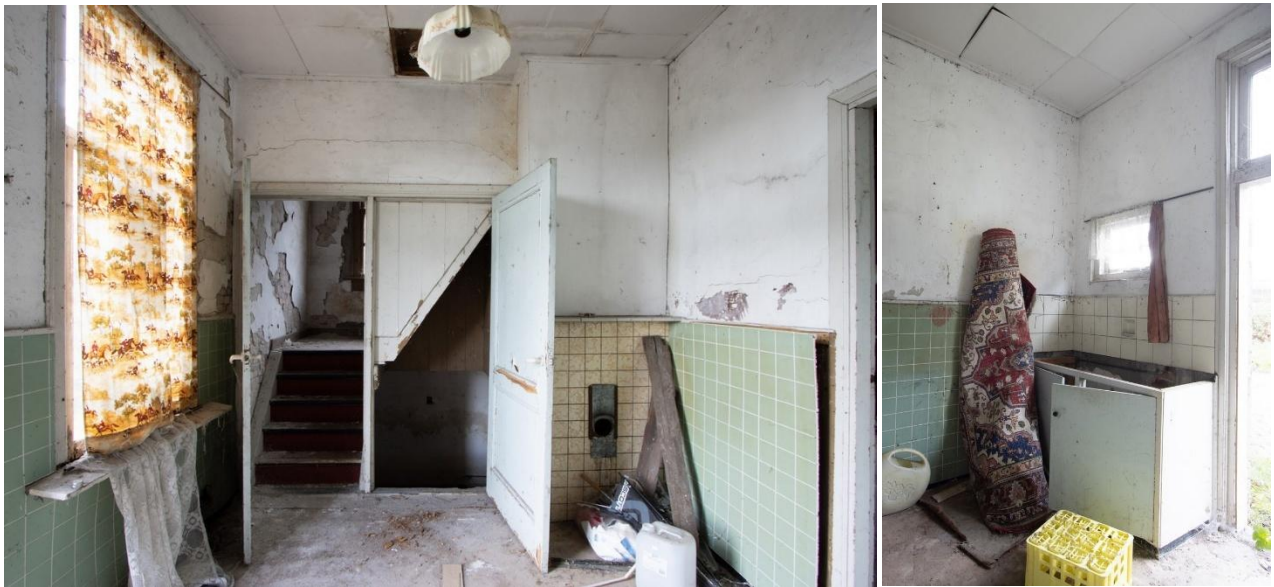
De deuren naar de opkamer en kelder in geopende toestand. De keldertoegang wordt gecombineerd met opgang naar de zolder. Op de rechterfoto het aanrechtblokje dat geplaatst werd nadat de plee op deze plek werd gesloopt. Tegen de gevel 'echte' wandtegels (met zeepbakje) in plaats van de imitatietegels van de lambrisering.
