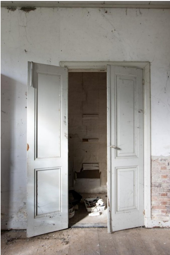
Eén van de bedsteden in halfgeopende toestand, met panelen aan de binnenzijde van de deuren. Rechts eerder getoonde afbeelding met metselwerk van de rechter zijgevel van het oudere buurpand Emerweg 55. We zien ook buizen uit de tijd dat de ruimte als hangkast diende.
