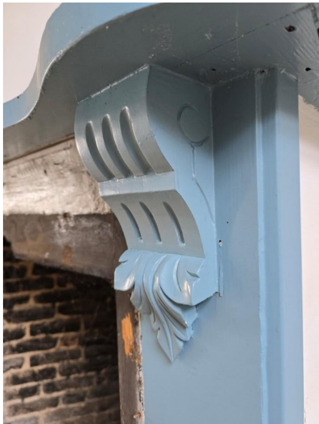
De haardpartij met houten mantel. Beroeting wijst op een open vuur. Rechts detail van één van de consoles in neostijl.
