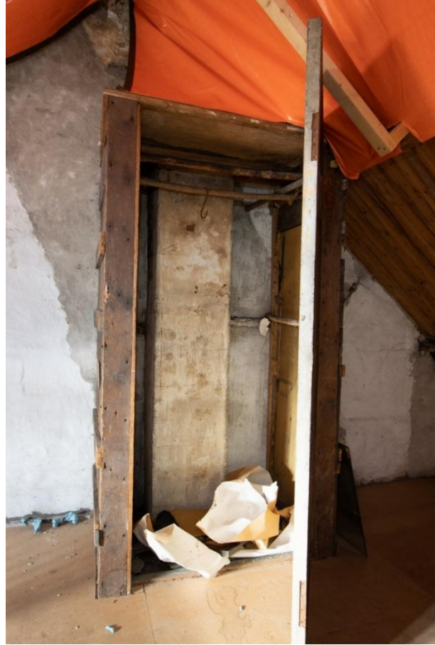
De kast op de zolder, met negentiende-eeuwse (hergebruikte deur). Achter de kast de aftekening van het oorspronkelijke rookkanaal dat naar de nok was gesleept. In de kast het rookkanaal dat in 1938 werd gemaakt ten behoeve van de stookplaats in de keuken.
