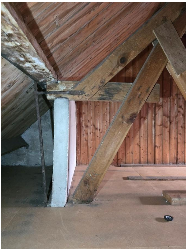
Op de onderzijde van de muurplaats is de aftekening te zien van de in 1938 gesloopte achtergevel. Het muurtje dat we nu zien, is in 1938 opgetrokken bovenop een in dat jaar aangebrachte stalen balk waarin de enkelvoudige balklaag van de zoldervloer werd opgelegd. De rechterfoto toont vermoedelijk de dichtzetting van de doorgang voor het rookkanaal van de in 1938 gesloopte inpandige oven.
