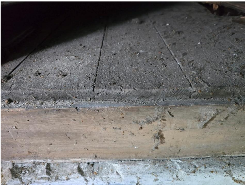
Vloerdelen ter plaatse van het trapgat. Op de muur heeft men een aan deze zijde ongeprofileerde vloerbalk gelegd. Op de rechterfoto het venster en het rookkanaal tegen de rechter zijgevel van het pand.
