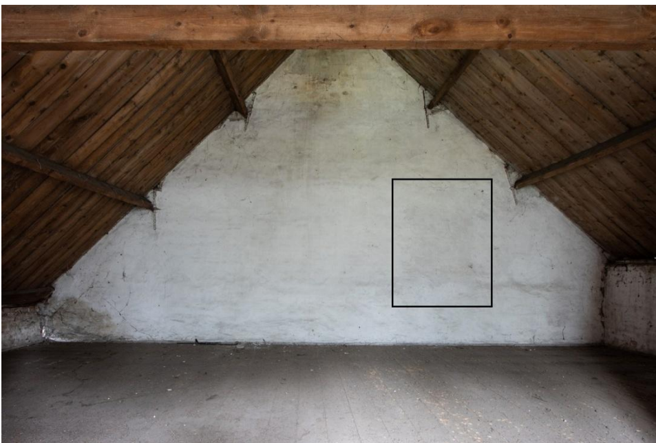
De rechter zijgevel vanaf de zolder van het aangebouwde Emerweg 57. Het kader is getekend om een dichtgezette vensteropening die zich aftekent in onder andere een donkerdere tekening van het later aangebrachte pleisterwerk.
