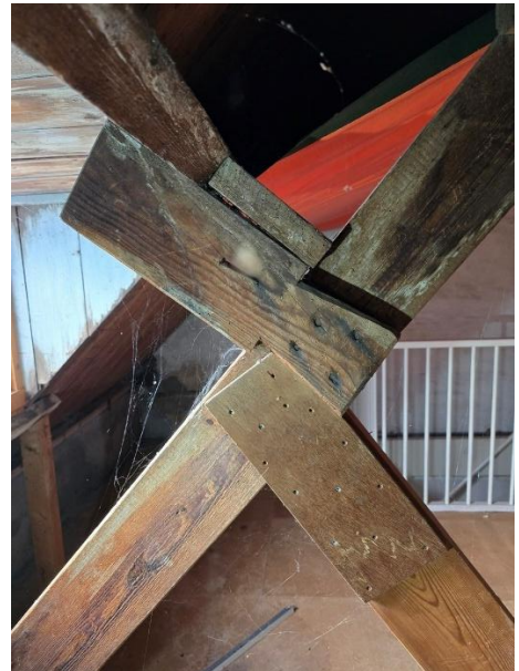
Detail van de aansluiting van het blokkeel op het spantbeen. Rechts de op afstand geplaatste gording ter plaatse van de dakkapel.
