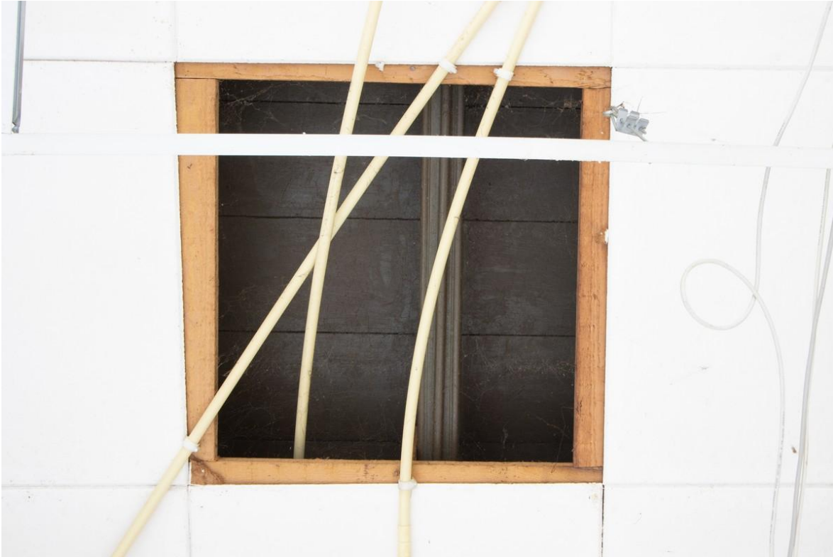
De balklaag en zoldervloer in de keuken zijn vergelijkbaar met de situatie in de woonkamer.
