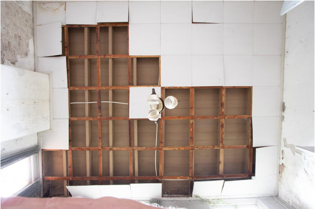
De balklaag en zoldervloer die tevoorschijn komt na verwijdering van de softboard panelen.
