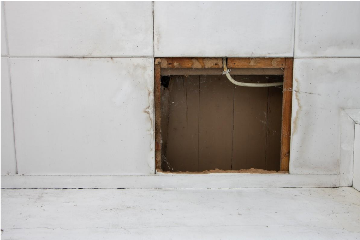
Plafond met daarboven de groen beschilderde balklaag en vloerdelen van de zoldervloer. Ook hier zijn de balken niet geprofileerd.
