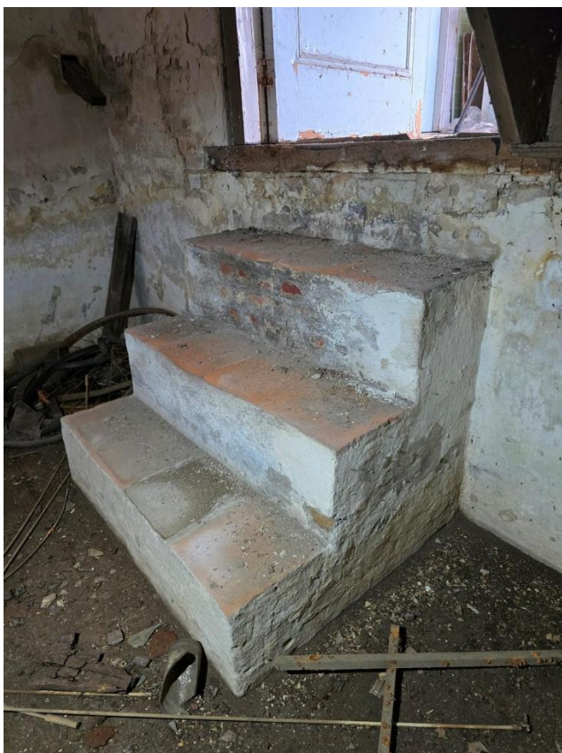
De bakstenen trap in de kelder, afgedekt met plavuizen. Rechts één van de balkjes ten behoeve van de verdwenen legplanken.
