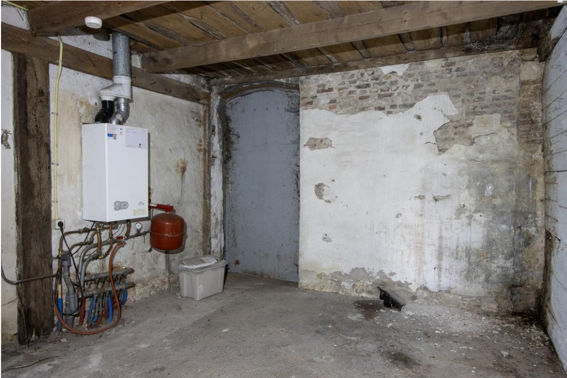
In het interieur dezelfde deur. In het interieur tekent zich, rechts op de foto, een duidelijke bouwnaad af. Het betreft een oudere dagkant met restanten van duimen. Het metselwerk tussen de deuropening en de naad is een dichtzetting die zich in het exterieur niet laat zien. Vermoedelijk hebben hier in het verleden deeldeuren gezeten en is het oudste metselwerk van de voorgevel nog (laat) negentiende-eeuws.
