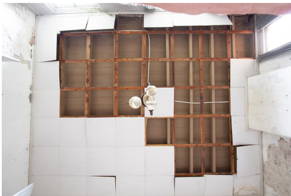
De balklaag van de zoldervloer in de woonkamer.
