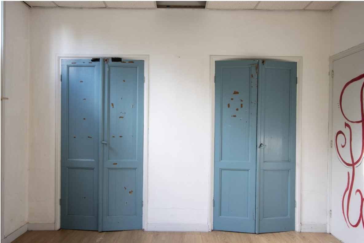
De wand met de bedstedeuren is niet oorspronkelijk. De wand is uit de tijd dat in de bedsteden de zoldertrap werd gemaakt. Mogelijk zijn daarbij deuren uit de gesloopte bedstedenwand hergebruikt.
