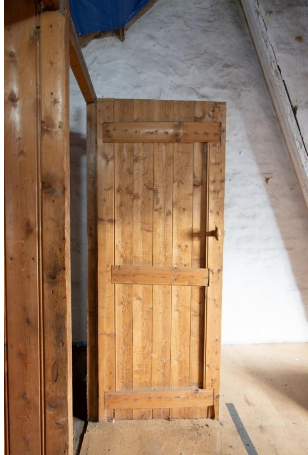
In het kamertje is de zoldervloer te zien. De delen zijn zonder twijfel uit de bouwtijd van het pand. Rechts de deur, provisorisch gemaakt met kraaldelen en draadnagels.
