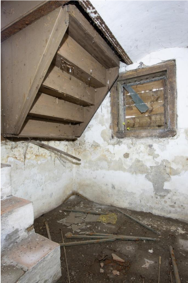
In de kelder is de trap van de opkamer te zien én een kelderlicht in de achtergevel. Op de rechterfoto dezelfde trap vanuit de keuken.
