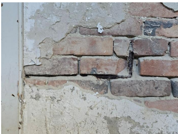
Detail van een kozijnanker in de dragende tussenmuur. Op de rechterfoto nog eens de sporen van een dichtgemetselde vensteropening in de rechter zijgevel van Emerweg 55.
