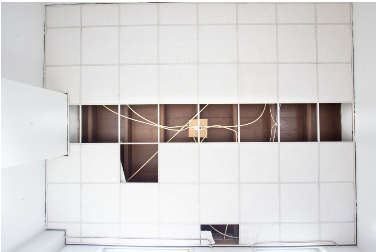
Plafond in de woonkamer met boven het systeemplafond de geprofileerde enkelvoudige balklaag en de bijbehorende zoldervloer.
