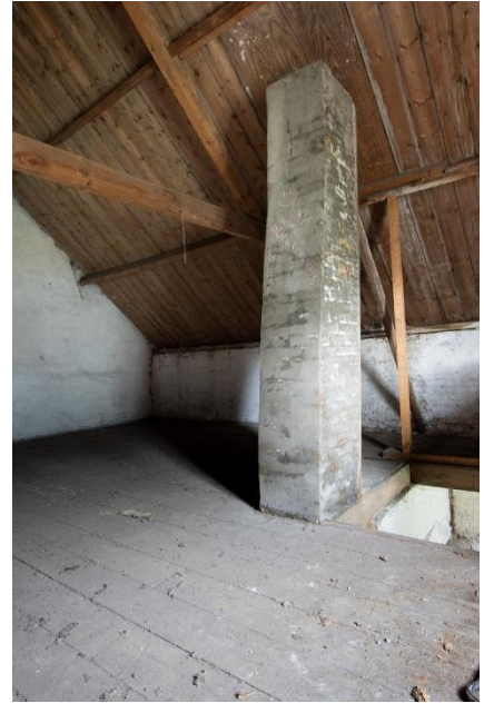
De zolder gezien in de richting van Emerweg 55. Rechts het vrijstaande rookkanaal, ontdaan van schoorsteen.
