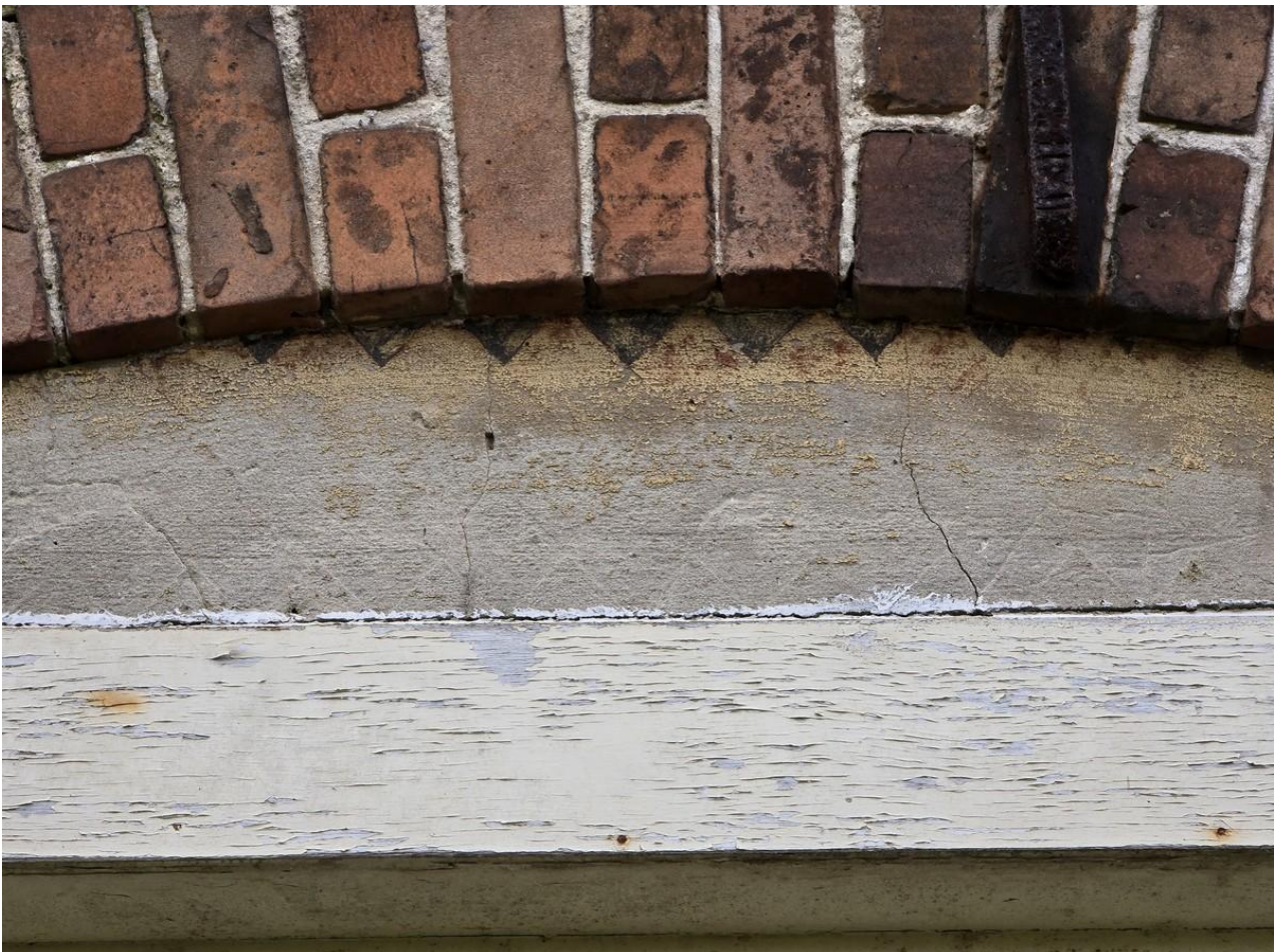
In de achtergevel is, beter dan in de overige gevels, het restant van schildering tussen segmentboog en kozijn te zien. We herkennen hier ook wat makkelijker het diagonale blokpatroon dat vermoedelijk in de cementpleister is gekrast voordat de schilder de kwast ter hand nam.
