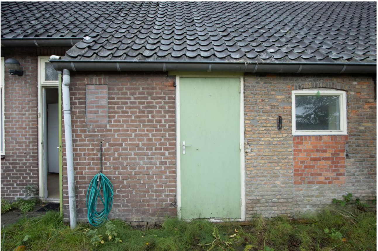
Het toiletraam in het metselwerk uit 1938 is dichtgemetseld. Deur en venstertje zijn volgens tekening uit 1938 in de plaats gekomen van deeldeuren. Secundair metselwerk tussen deur en venster lijkt hiermee overeen te stemmen.
