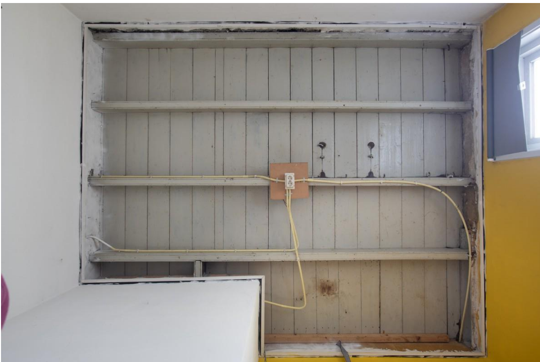
De zoldervloer gezien vanuit de slaapkamer. Middenonder het voormalige trapluik met daarop aansluitende raveelbalk waar later onder tegenaan een kast is gemaakt.
