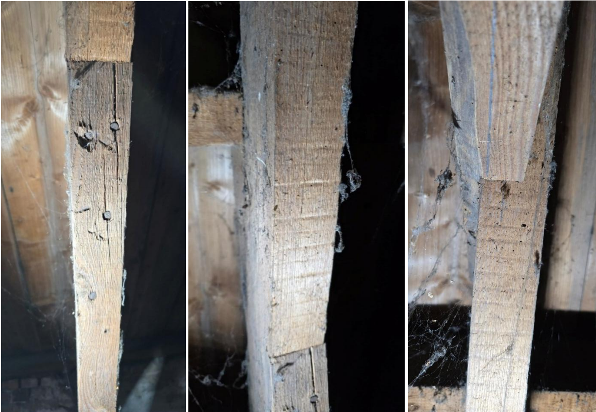
Details van de kapconstructie met links de spijkerkoppen bij de aansluiting van kreupele stijl op spantbeen. In het midden sporen van lintzaag en rechts de aansluiting van de trekbalk op het spantbeen (ingelaten).
