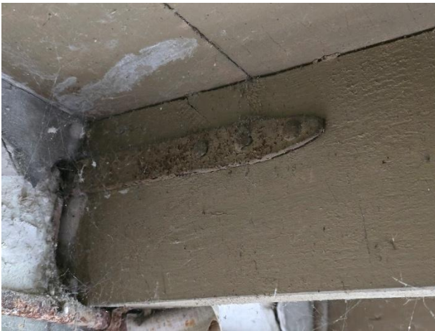
Verankering van een vloerbalk met de achtergevel (opkamer) en spijkers waarmee de raveelbalk voor het trapgat is vastgezet (opkamer).
