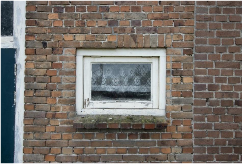
Boven het secundaire venster is een rollaagje te zien dat behoort heeft bij een toiletvenster. Rechts op dezelfde foto de bouwnaad tussen de achtergevel van Emerweg 57 (circa 1922) en de in 1938 nieuw gemetselde achtergevel van Emerweg 55. Op de rechterfoto het huisnummer 57 met ook hier bakstenen met vingerafdrukken.
