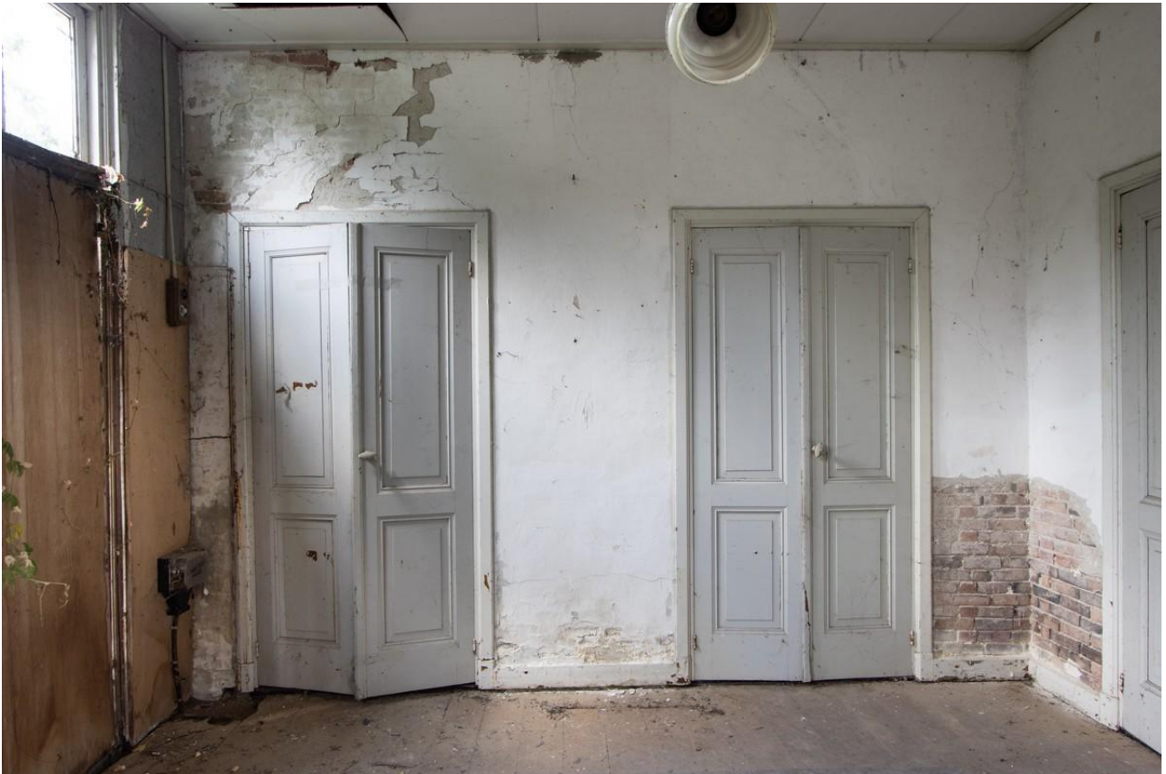
De bedstedenwand met deuren uit de bouwtijd. Typologisch zijn de deuren vrij ouderwets vormgegeven. Het zijn late voorbeelden.
