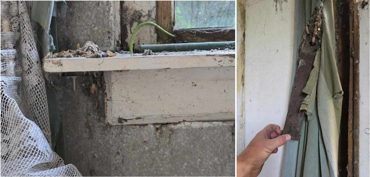
Detail van de vensterbank bij het venster in de voorgevel. Let op de ongeprofileerde wellat onder de vensterbank. Op de rechterfoto het schuifijzer van het onderraam in de rechter zijgevel.
