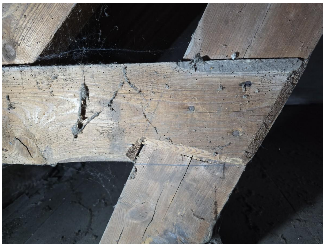
De aansluiting van het blokkeel op de kreupele stijl, waar potloodlijnen en de koppen van draadnagels duidelijk zijn te zien. Bij de blokkeels zijn vellingkanten aangesneden.
