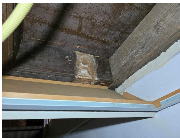
De vloerbalken zijn met een kraal geprofileerd. De aftekening op de raveelbalk van het trapgat markeert de plek van de muur tussen beide bedsteden vóór het hergebruik van dit balkfragment ten behoeve van het huidige trapgat.
