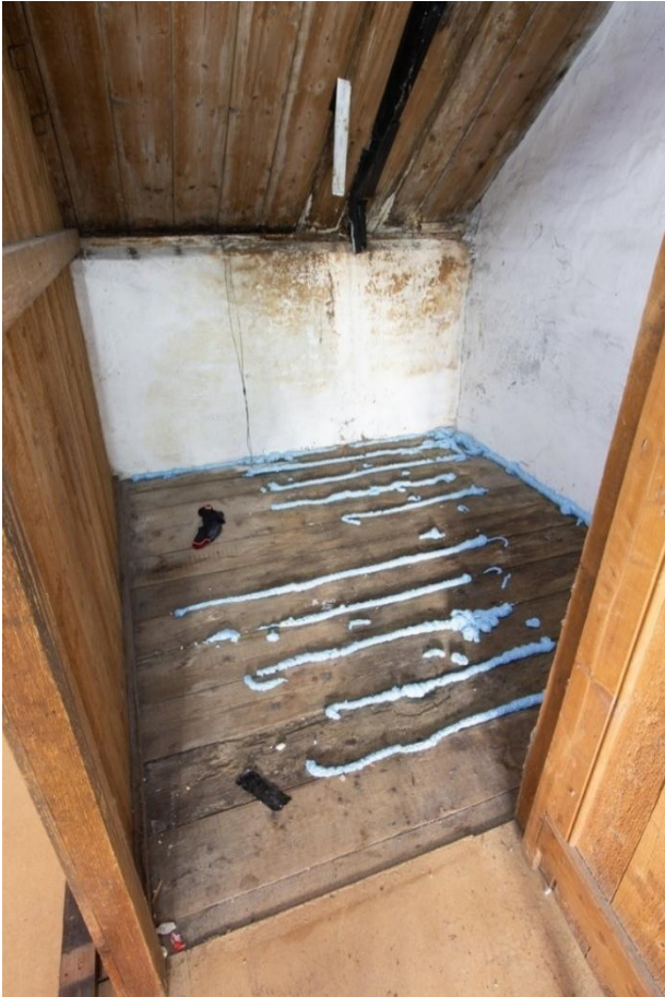
In het kamertje is de zoldervloer te zien. De delen zijn zonder twijfel uit de bouwtijd van het pand. Rechts de deur, provisorisch gemaakt met kraaldelen en draadnagels.
