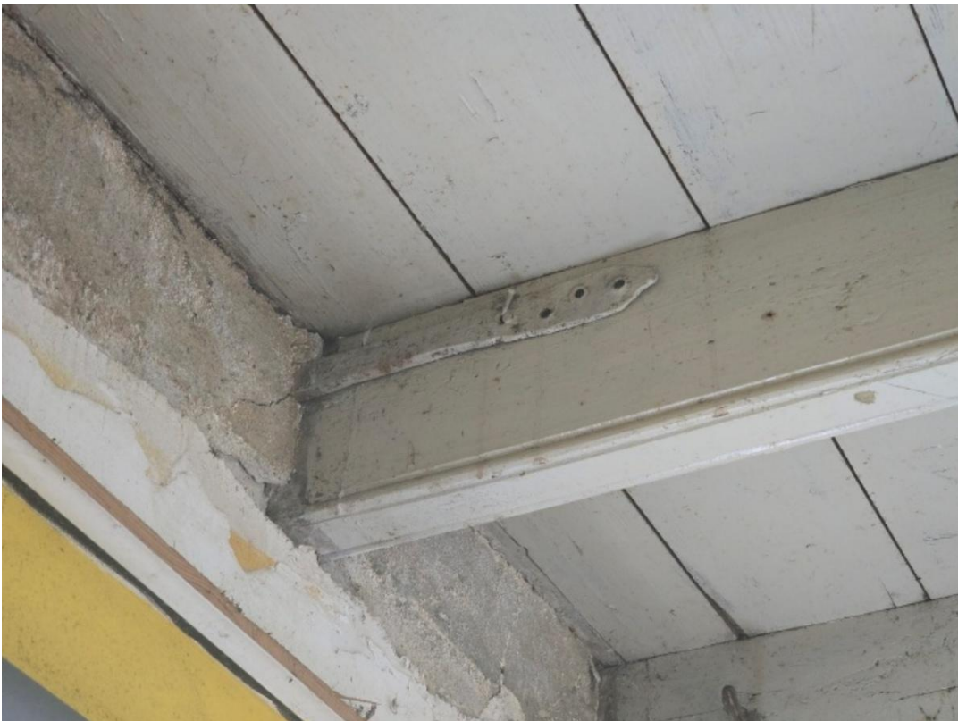
Bij het maken van de nieuwe achtergevel bleef de zoldervloer in tact. We zien dat de veer van een anker in 1938 opnieuw aan een bestaande vloerbalk is vastgezet (met een enkele spijker).
