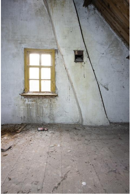
Vloerdelen ter plaatse van het trapgat. Op de muur heeft men een aan deze zijde ongeprofileerde vloerbalk gelegd. Op de rechterfoto het venster en het rookkanaal tegen de rechter zijgevel van het pand.
