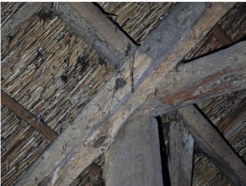
Detail van een geboute verbinding. Rechts de kreupele stijl aan de zijde van de voorgevel.
