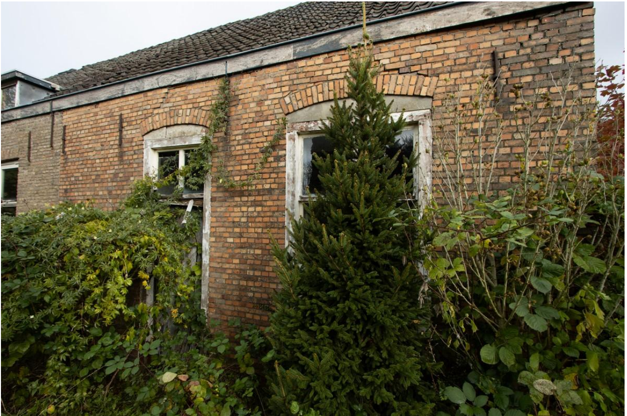
De voorgevel van Emerweg 57 geeft blijk van de beperkte omvang van dit huis.
