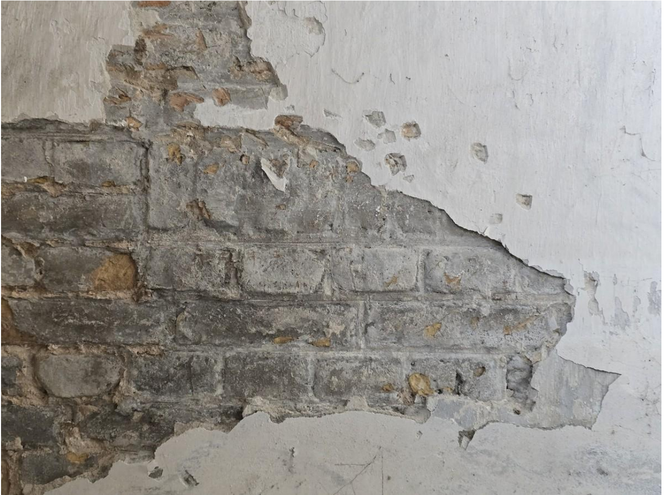
In de achterwand van de bedstede in Emerweg 57 is voegwerk met een daggestreep te zien, alsmede de rollaag die de onderzijde markeert van een dichtmetselde vensteropening in de voormalige gevel. Voegwerk en baksteenformaten zijn een indicatie dat deze gevel nog wel eens van vóór 1907 kan dateren.
