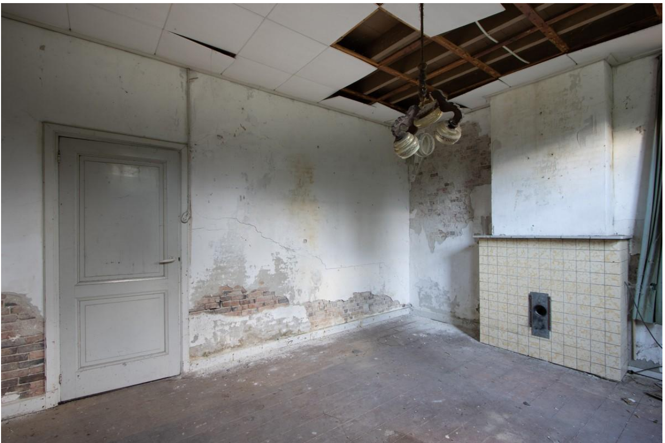
De kamerdeur in de dragende scheidingsmuur. Metselwerk is duidelijk uit het eerste kwart van de twintigste eeuw.
