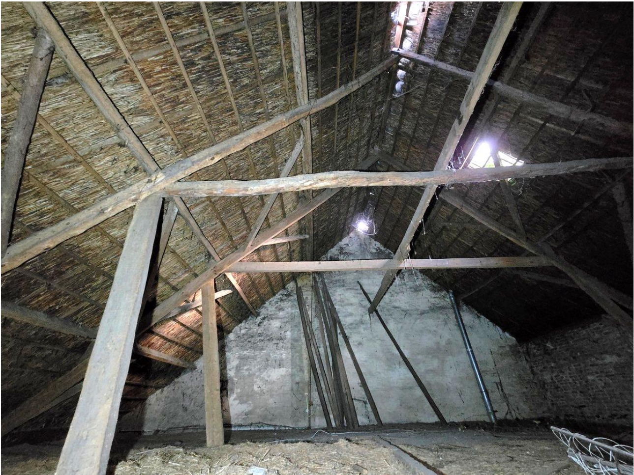
De zolder boven het bedrijfsgedeelte.
