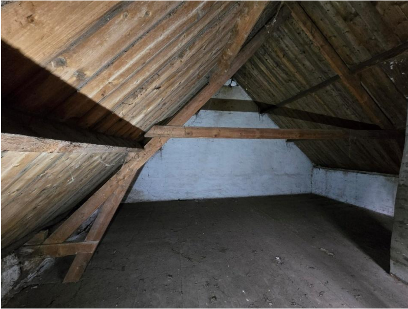
De zolder gezien in de richting van Emerweg 55. Rechts het vrijstaande rookkanaal, ontdaan van schoorsteen.
