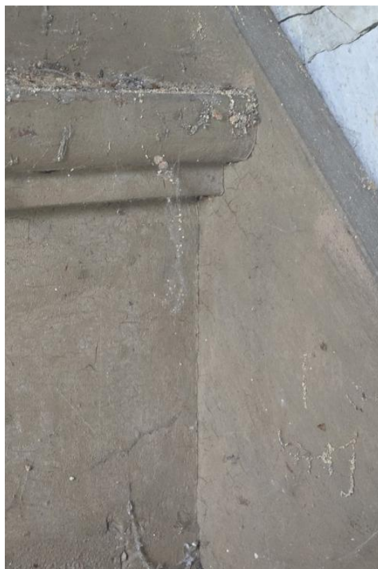
De zoldertrap in de opkamer. Rechts detail van de trap met profilering van een trede.
