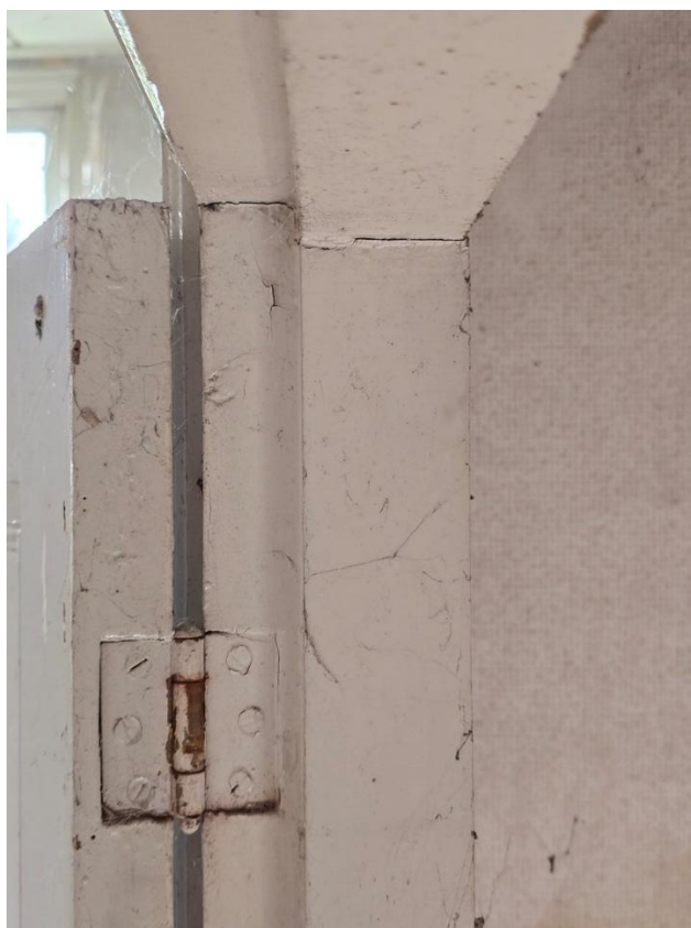
Detail van deur, kozijn en perklijsten van één van de bedstede deuren. Rechts detail van kozijn en deurscharnier.
