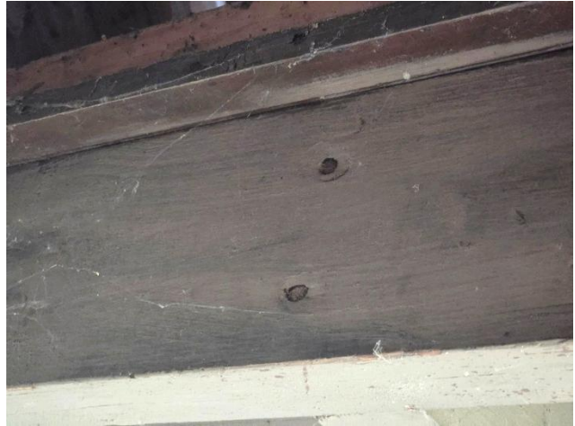
Verankering van een vloerbalk met de achtergevel (opkamer) en spijkers waarmee de raveelbalk voor het trapgat is vastgezet (opkamer).
