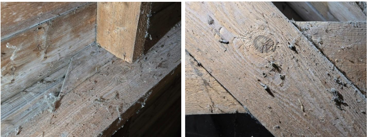
In detail gording en gordingklos op het spantbeen. Rechts is te zien dat de spijkers waarmee de trekbalk aan het spantbeen zijn gezet, niet zijn omgeslagen (de spijkers zijn daarvoor ook nét te kort).
