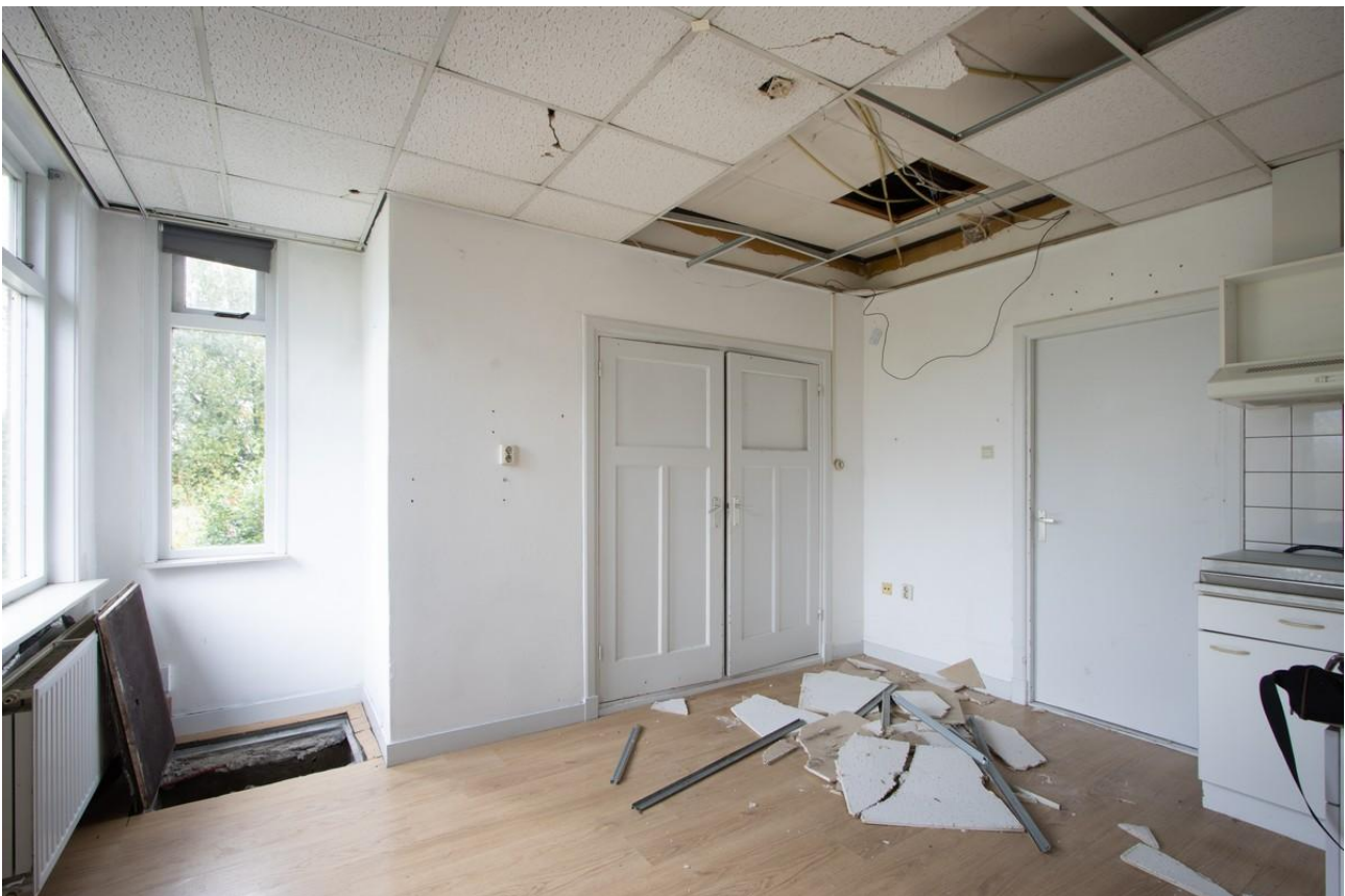
De keuken gezien in de richting van de rechter zijgevel, met rechts de (vernieuwde) deur naar de woonkamer.
