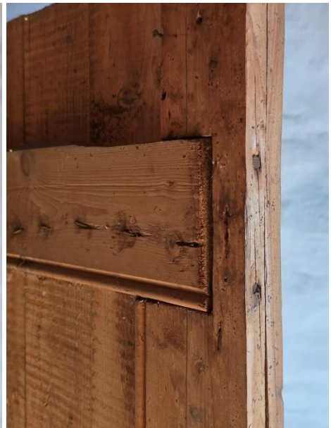
In het kamertje is de zoldervloer te zien. De delen zijn zonder twijfel uit de bouwtijd van het pand. Rechts de deur, provisorisch gemaakt met kraaldelen en draadnagels.
