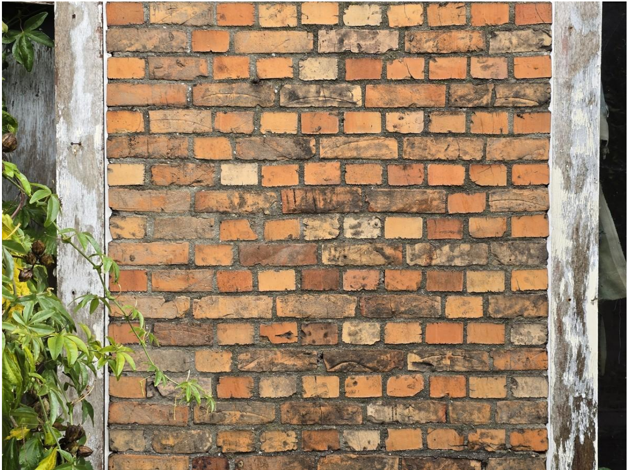
Muurdam tussen de beide gevelopeningen met oorspronkelijke dagkanten en metselwerk in kruisverband.
