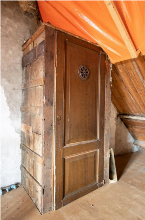
De kast op de zolder, met negentiende-eeuwse (hergebruikte deur). Achter de kast de aftekening van het oorspronkelijke rookkanaal dat naar de nok was gesleept. In de kast het rookkanaal dat in 1938 werd gemaakt ten behoeve van de stookplaats in de keuken.
