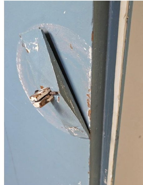
Kruk en details van de bedstede deur wijzen er op dat de deuren uit de bouwtijd zijn, en in de niet-oorspronkelijke wand zijn hergebruikt op het moment dat in de bedsteden de zoldertrap kwam.
