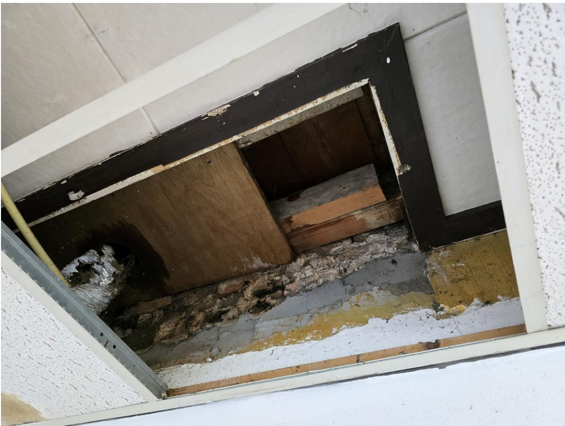
Sporen van een verdwenen rookkanaal voor een stook- en kookplaats die op tekening uit 1938 als te maken is aangeduid.
