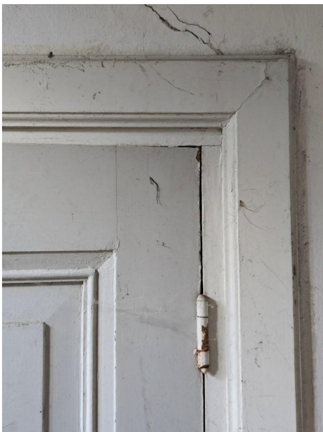
Detail van deur, kozijn en perklijsten van één van de bedstede deuren. Rechts detail van kozijn en deurscharnier.
