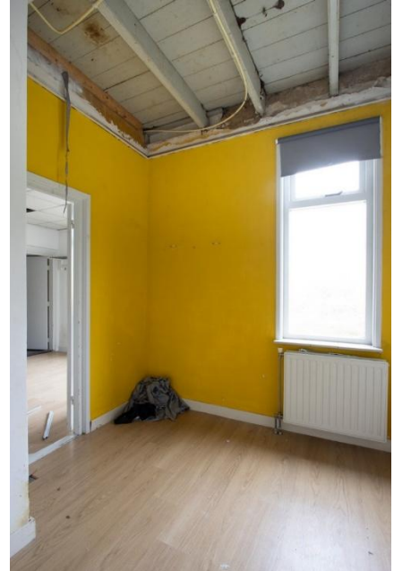
Betonvloer in de slaapkamer. De vloer is in de plaats gekomen van een hoger gesitueerde opkamervloer, vermoedelijk zoals thans nog aanwezig in het buurpand. Rechts opname van de slaapkamer richting de achtergevel.
