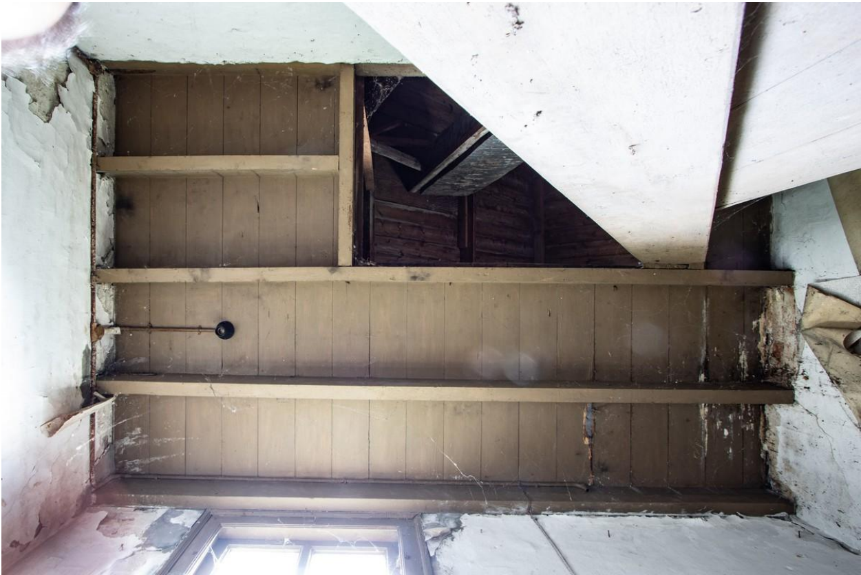
Constructie van de zoldervloer in de opkamer, met oorspronkelijk trapgat. De raveelbalk is met draadnagels aan de vloerbalk gezet.
