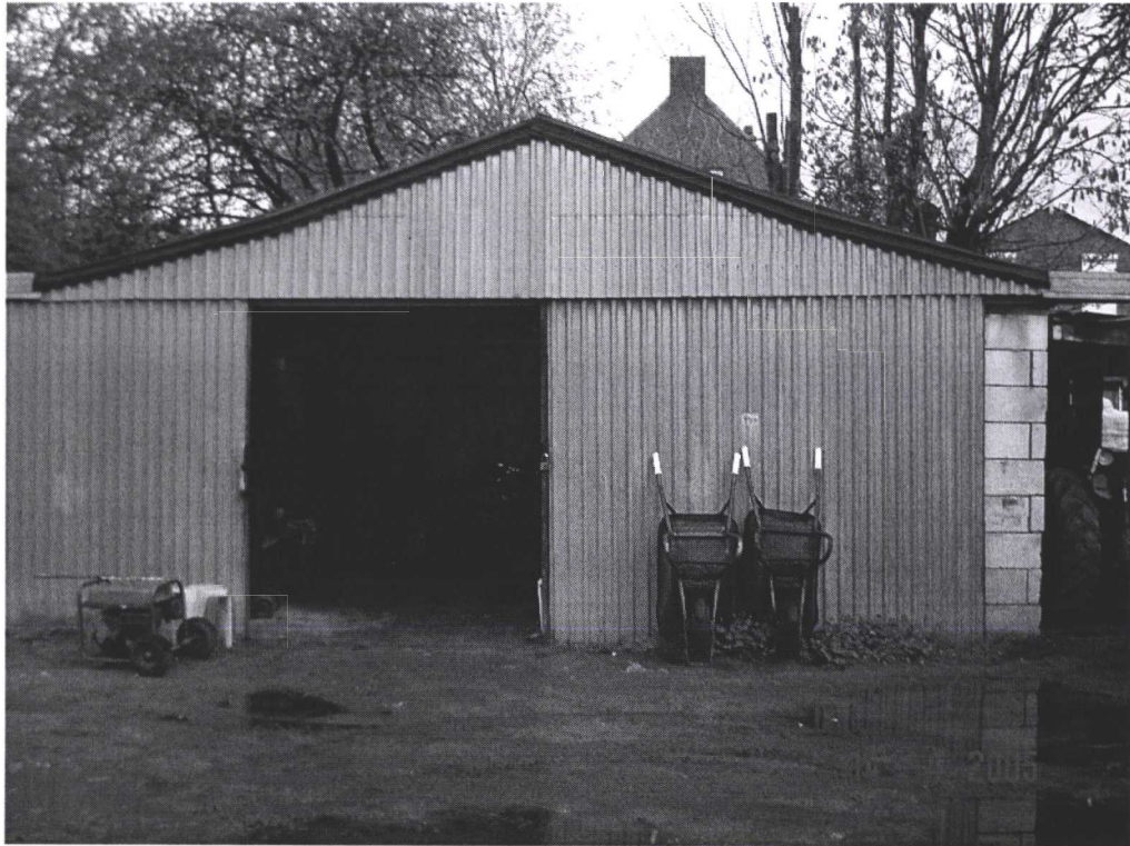
FOTO 1 ONDERZOEKSLOCATIE T.P.V. DE OLIEOPSLAG IN DE SCHUUR
