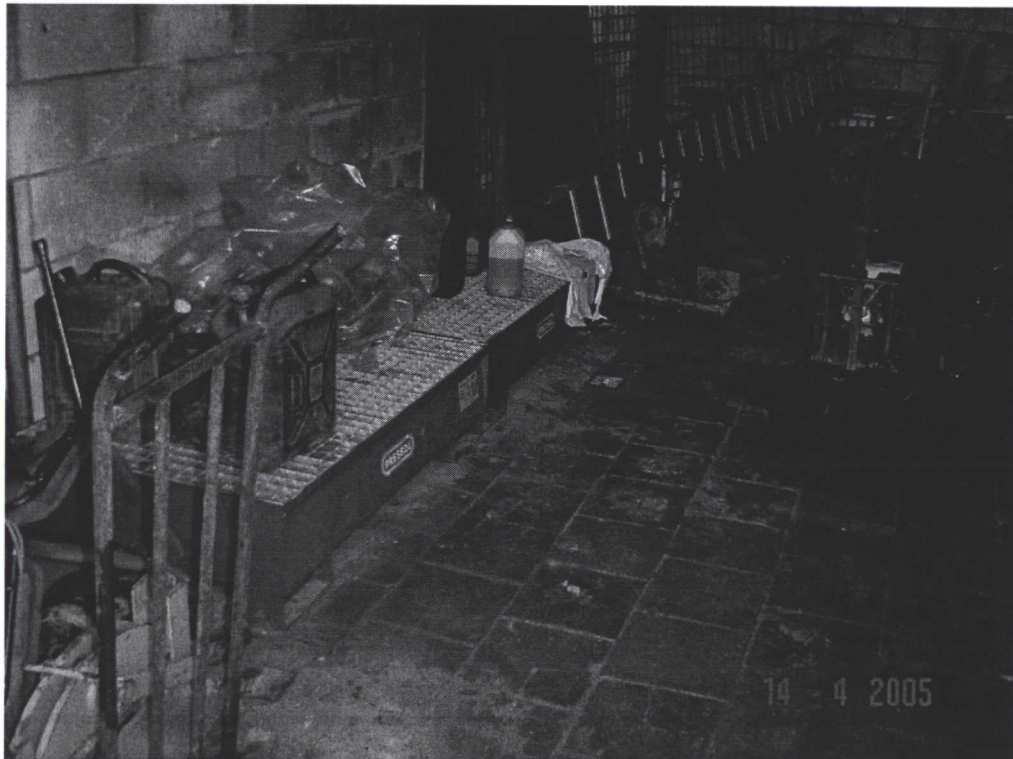
FOTO 2 OLIEOPSLAG IN DE SCHUUR
